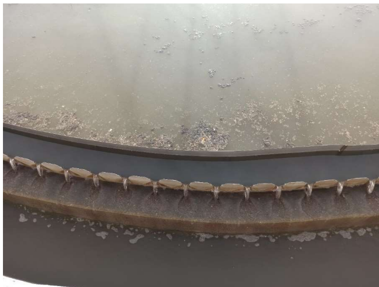
Figura 2. Presencia de sólidos suspendidos en el sedimentador primario
