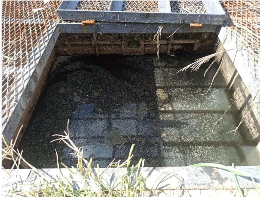
Figura 1. Presencia de solidos suspendidos en la PTAR San Blas
