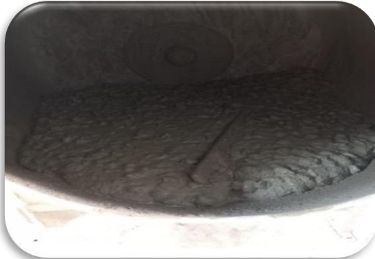
Figura 15. Estado final de la mezcla con trabajabilidad adecuada.
