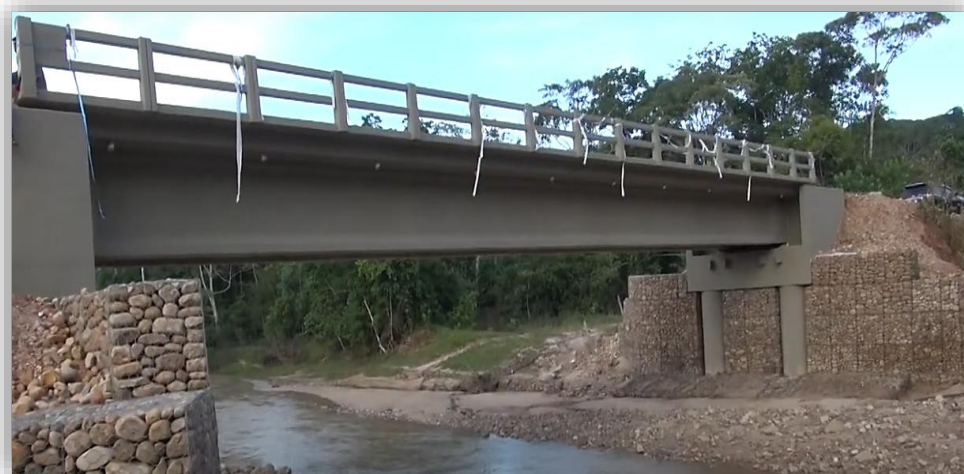
Figura 4.4 Puente “Amanecer B” Entre Ríos - Cochabamba
