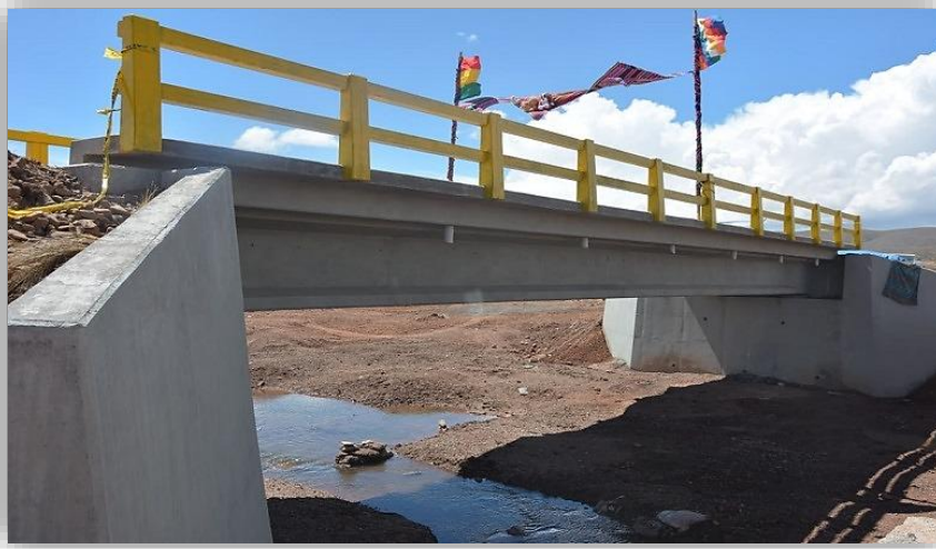
Figura 4.2 Puente con estribo cerrado en el Municipio de Laja
