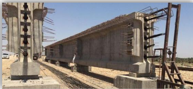
Figura 2.8. Vigas de hormigón postensado
