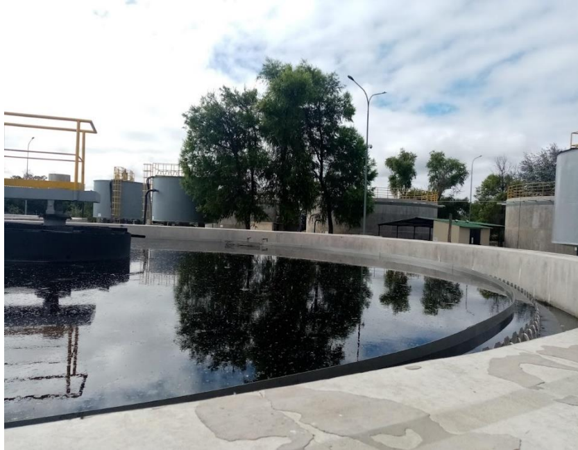
Figura 2.6 Planta de tratamiento de aguas residuales (Tarija)
