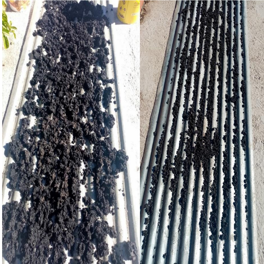
Figura 3.6 Deshidratación de lodos
