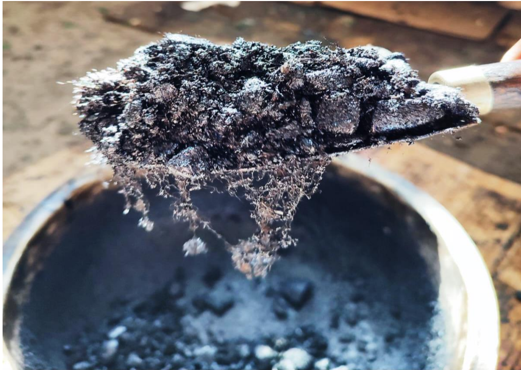
Microfibras en la mezcla asfáltica antes de la compactación
