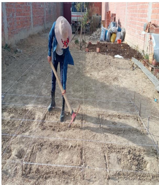
Demarcación de las platabandas
