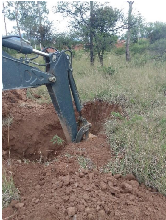
Escavacion del pozo 2
