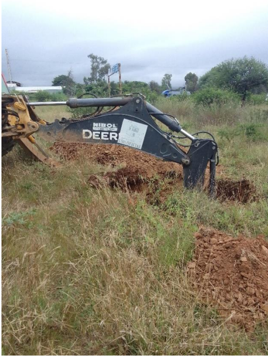
Excavacion del pozo 1
