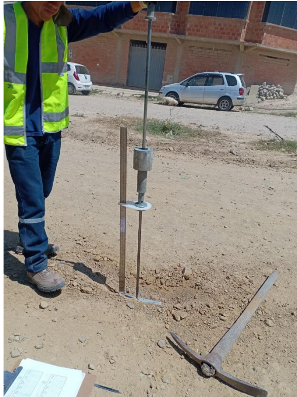
Equipo armado e inicio de ensayo
