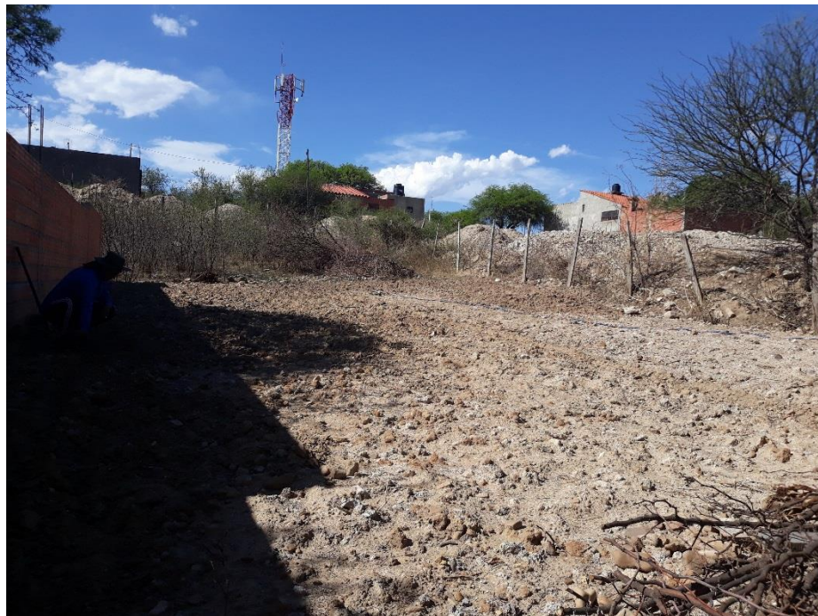
FOTO2.- PREPARACION DEL TERRENO
