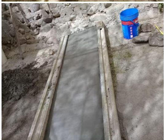
Platabandas de cemento
