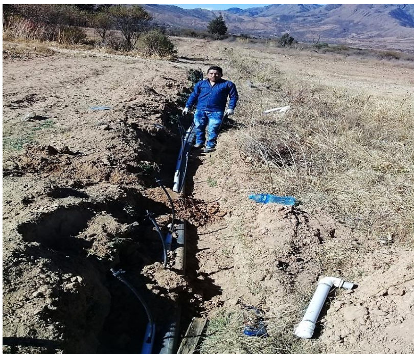
FOTOGRAFÍA ENTERRADO DEL SISTEMA DE RIEGO
