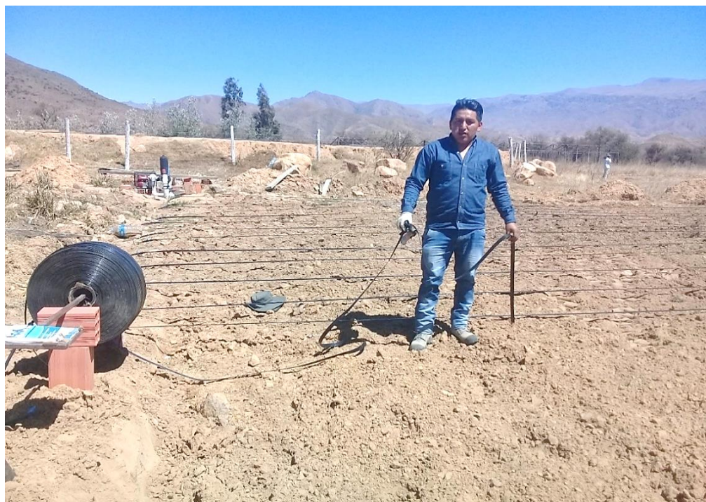
FOTOGRAFÍA ENTERRADO DE CINTA RIEGO SUBTERRANEO
