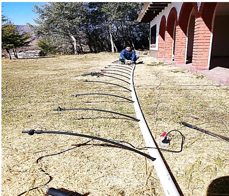
INSTALACIÓN DEL SISTEMA DE RIEGO POR GOTEO
