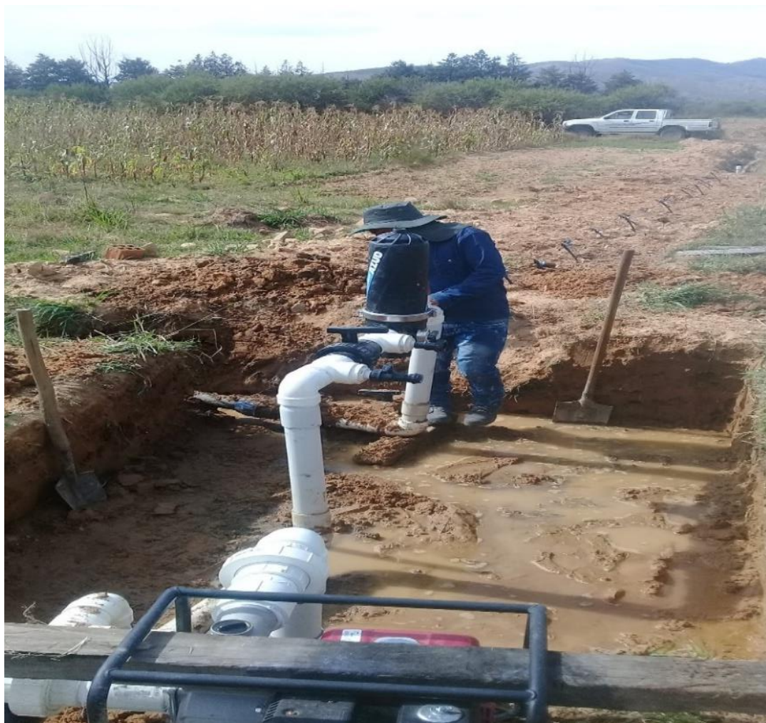
FOTOGRAFÍA INSTALACIÓN DEL VENTURI
