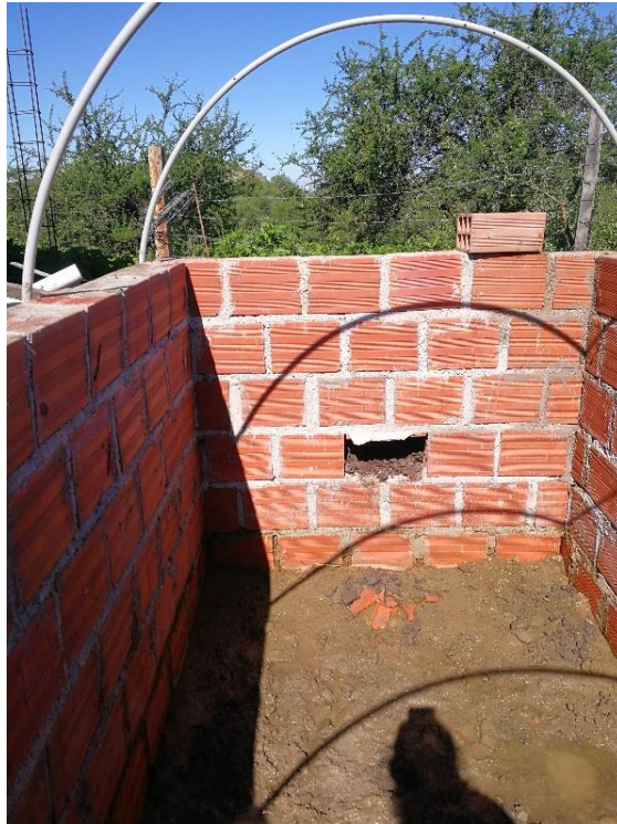
Figura 11 Adecuación de la Fosa
