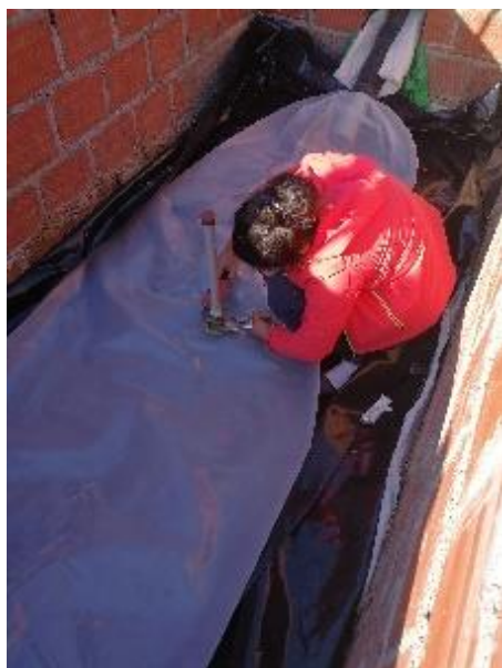
Figura 19 Colocación de los tubos de PVC de salida de gas de la manga, el reservorio y demás materiales
