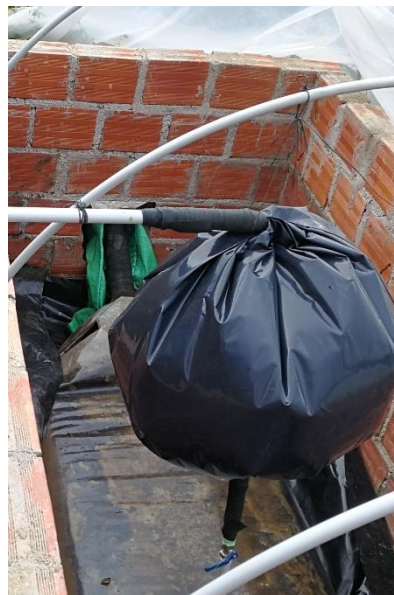
Figura 19 Colocación de los tubos de PVC de salida de gas de la manga, el reservorio y demás materiales
