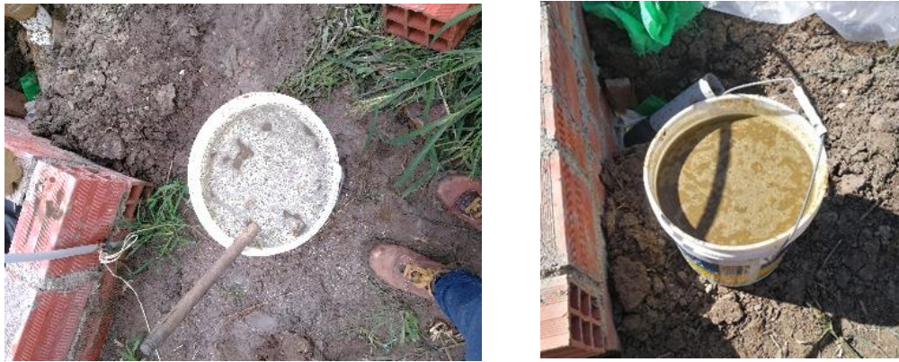
Figura 20 Acondicionamiento de mezcla estiércol- agua
