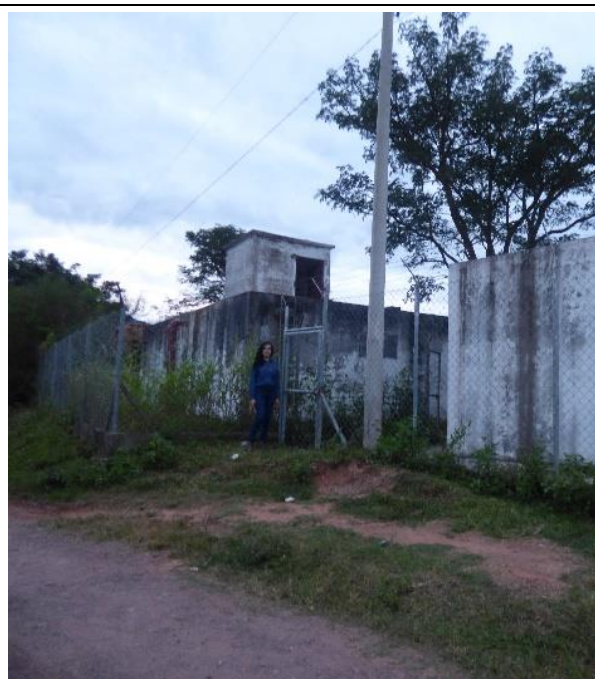
IMAGEN N° 41 P1: TANQUE CLORADOR
