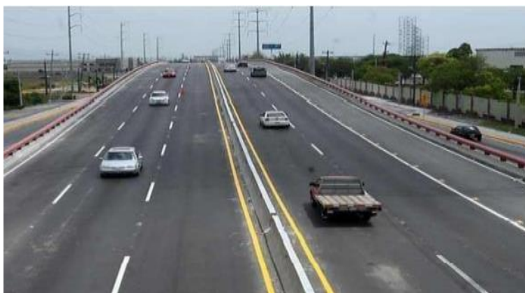
Figura N° 2.12 Nivel de servicio A
