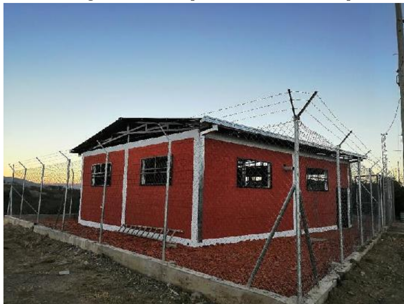
Fotografía 2. Cerco perimetral de malla olímpica
