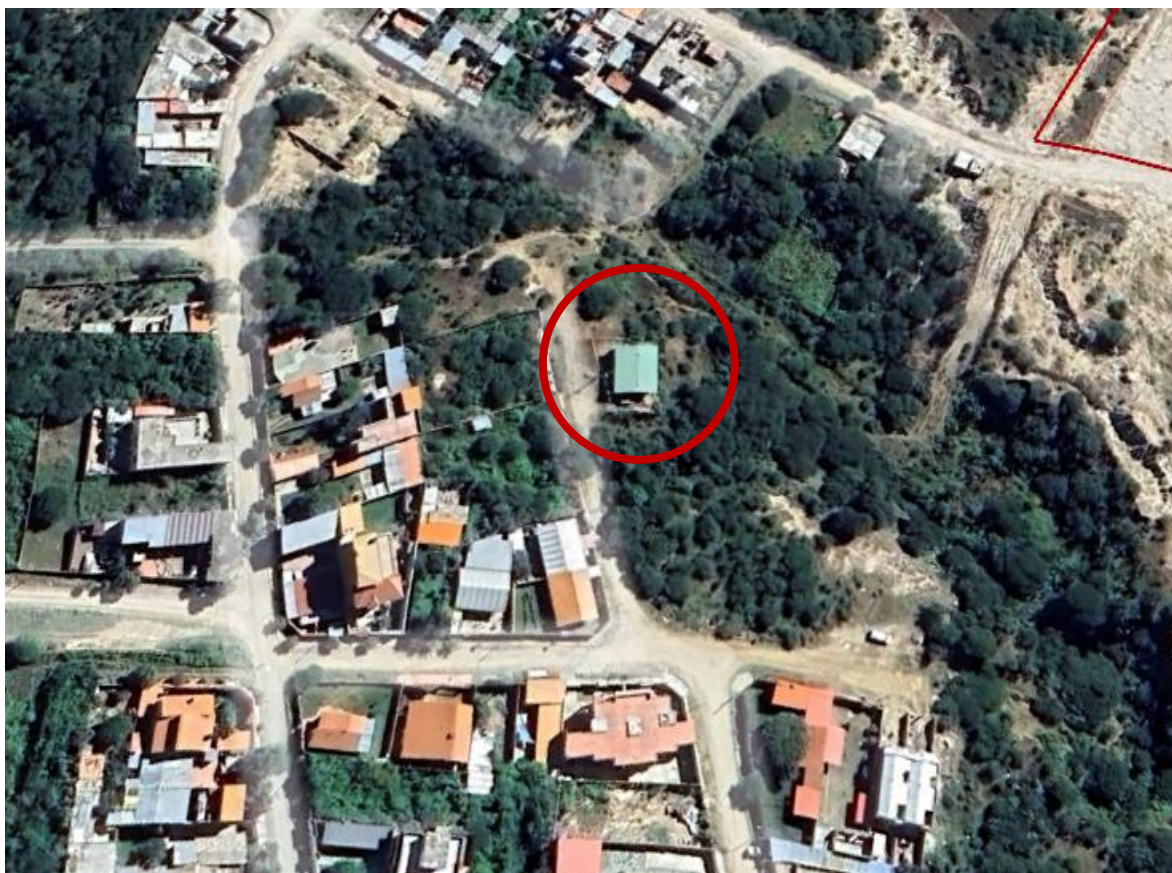
Fotografía 17. Fotografía satelital descriptiva de la PTAR.
