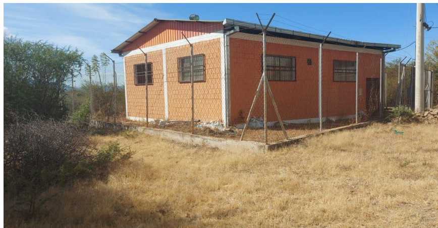
PTAR de Cossalt de aguas residuales ubicada en la zona del barrio Catedral
