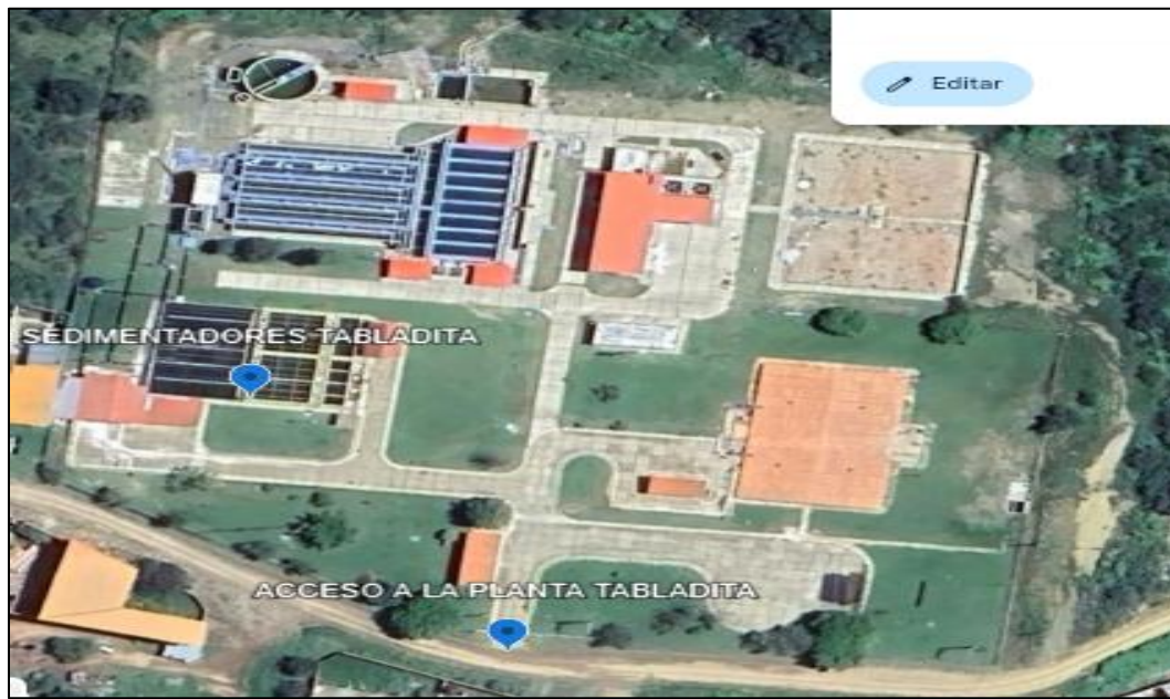
Figura 9. Acceso al sedimentador
