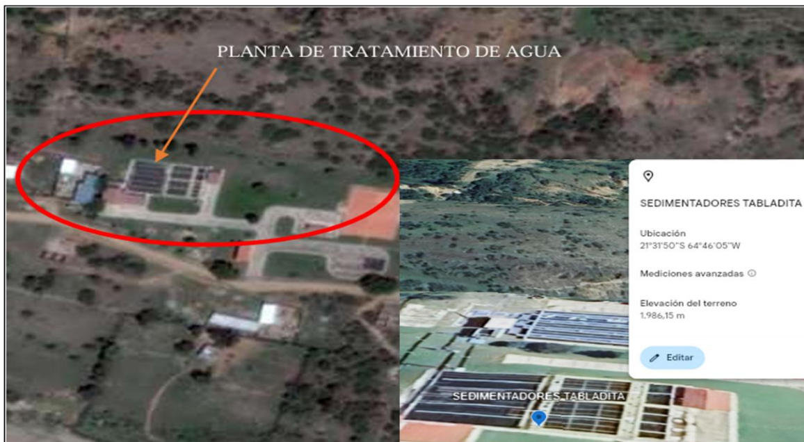
Figura 8. Instalación de la planta de tratamiento Tabladita COSAALT
