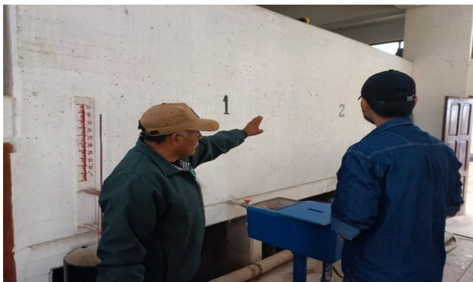
Figura B.6 Explicación del Operador sobre los rangos de dosificación de coagulante y los niveles de turbiedad de trabajo.
