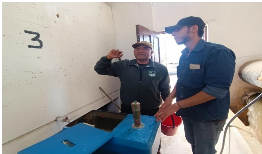
Figura B.7 Detalle del proceso de preparación y dosificación de productos químicos en la Planta de Tabladita.
