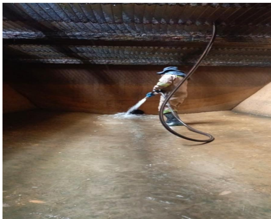
Figura B.4 Vista interna de la zona de salida del sedimentador durante la inspección interna.
