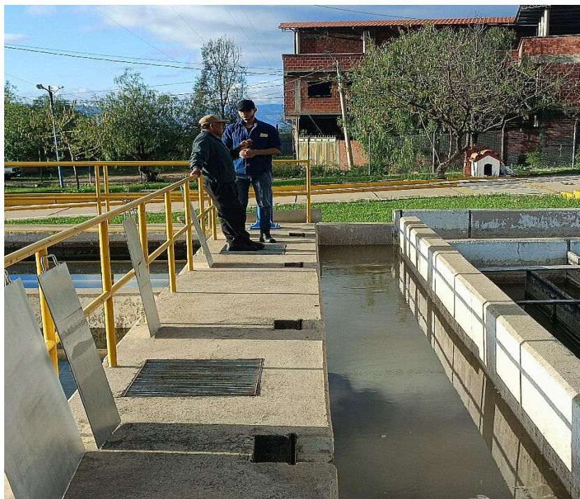
Figura B.5 Conversación con el Operador Naval Sánchez sobre el funcionamiento actual del sedimentador y las propuestas de mejora de la Planta.
