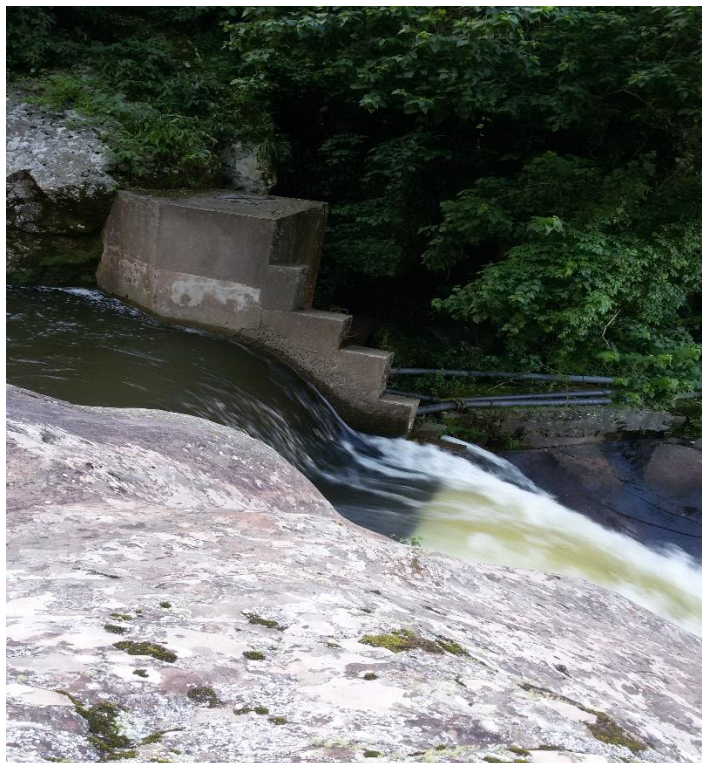
Foto 5: Obra de toma de agua potable del rio Trancas (Época de lluvia)
