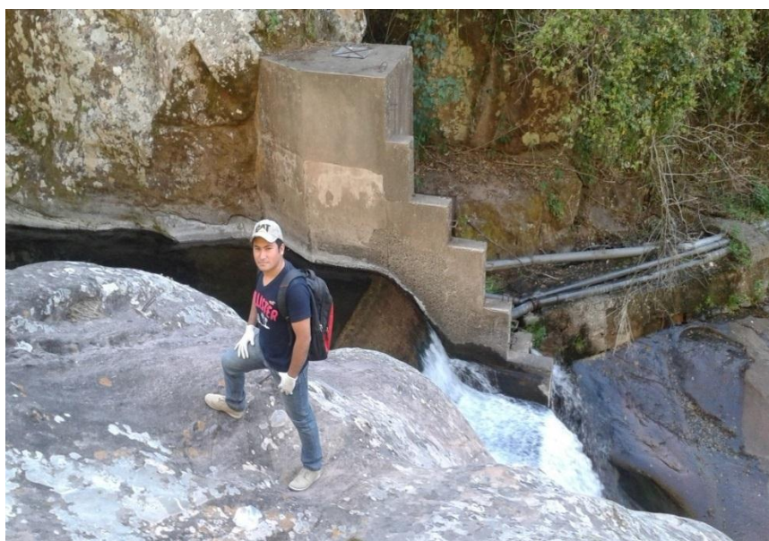
Foto 6: Obra de toma de agua potable del rio Trancas (Época de estiaje)
