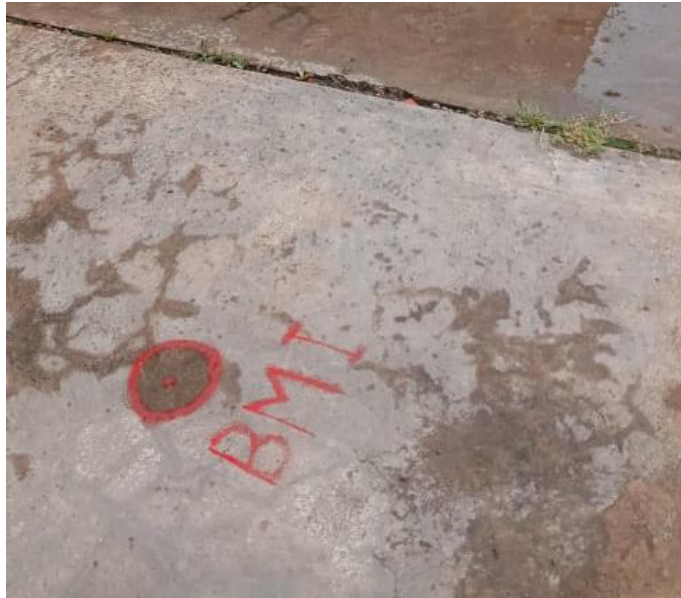
Imagen 18. Primer punto (BM Inicial ) del tramo de la carretera
