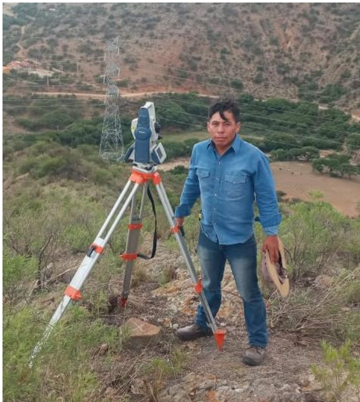
Imagen 18. Último punto (BM Final )del tramo de la carretera
