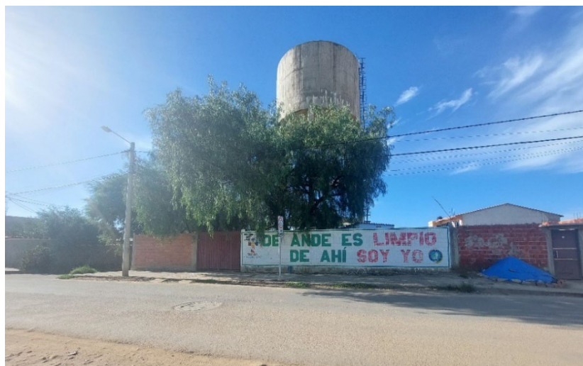
Figura 13 : Tanque elevado Luis Espinal. Fuente: Elaboración propia.
