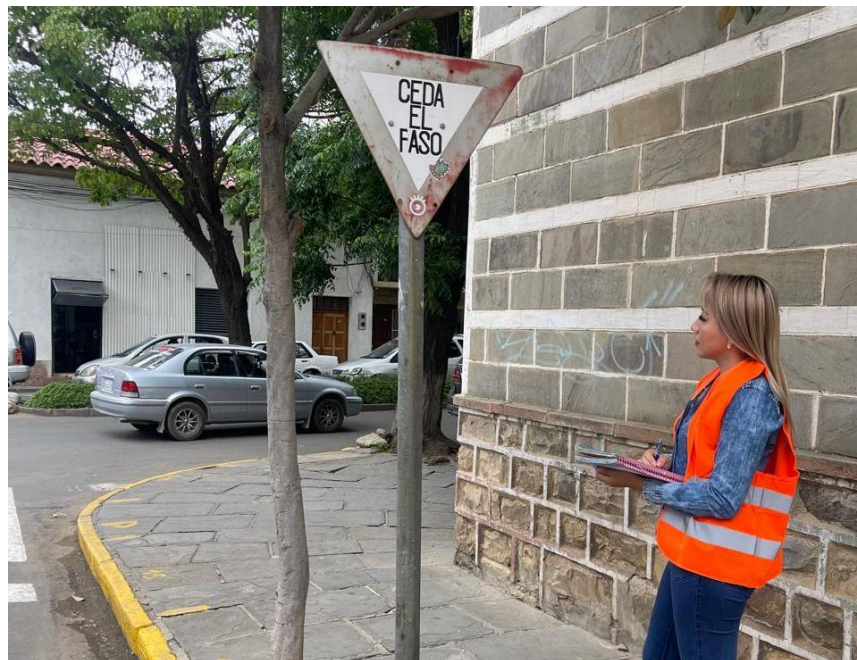
Figura 12. Inspección de señalización vertical 'Ceda el paso' para evaluación de visibilidad y estado.
