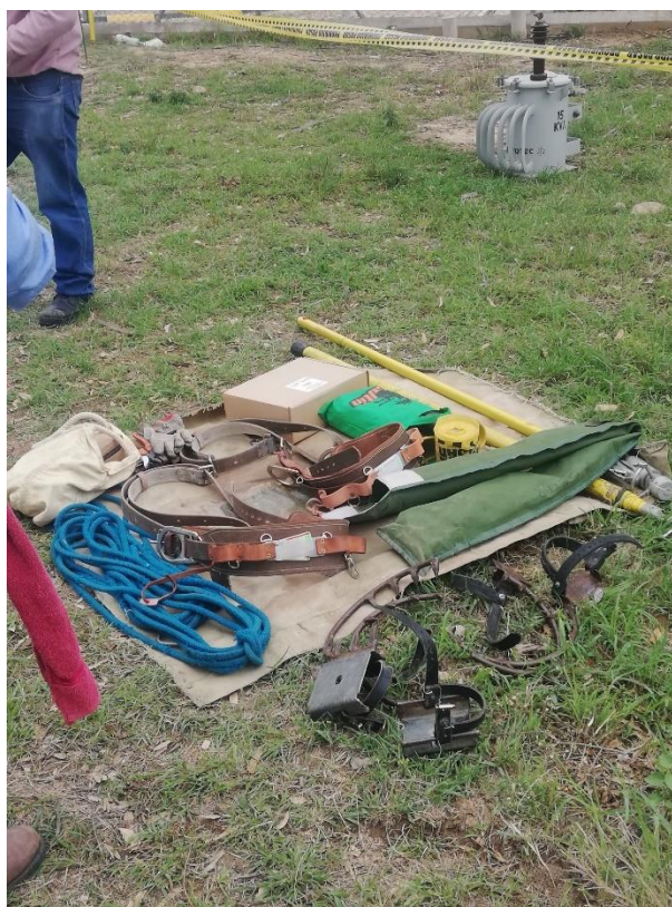
Equipos de protección personal utilizados por los trabajadores para el ascenso y descenso de poste de hormigón y de madera.
