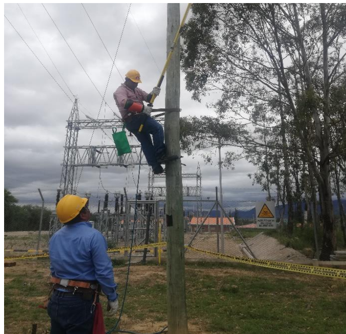
Trabajador haciendo corte visible de líneas para la seguridad de sus compañeros
