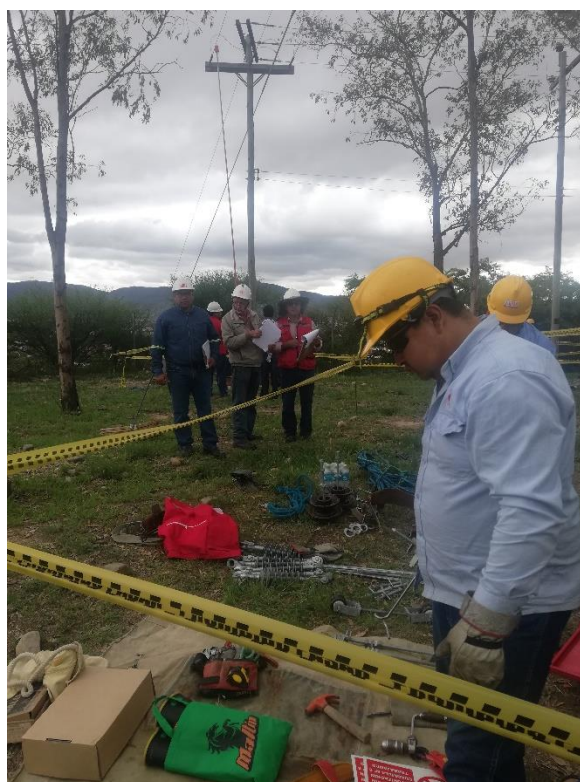
Equipos de protección personal utilizados por los trabajadores para el ascenso y descenso de poste de hormigón y de madera.
