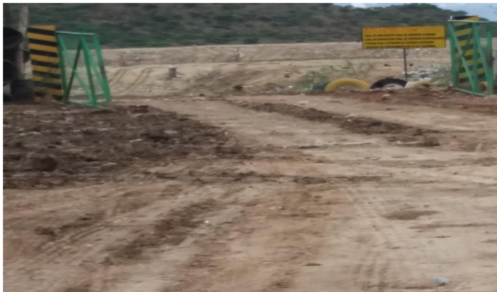
Entrada a la disposición final de los residuos sólidos.
