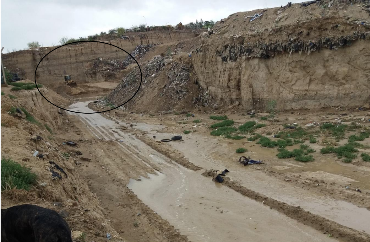
Se aprecia la maquinaria en la abertura de una nueva zanja.
