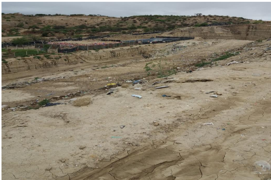
Vista del relleno de la zanja de residuos peligrosos y se nota la abertura de una nueva zanja.
