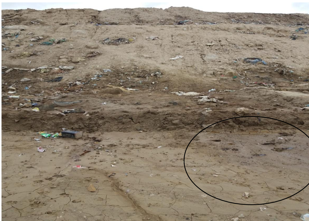
Se nota humedad en el suelo.
