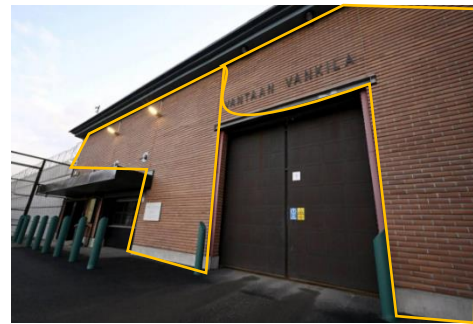
Figura 96: Acabado con ladrillo visto
