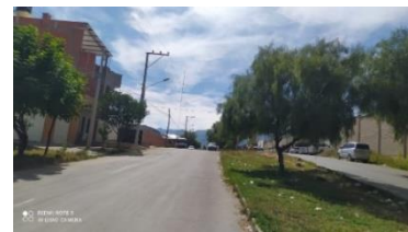
VISTA DE LA AV. Cnel CAMILO
