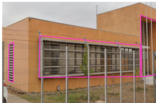
Figura 103: Ingreso de iluminación
