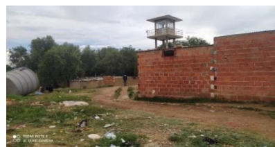
Figura 81: Vista sur Fuente: Del Autor
