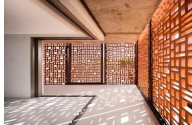
Figura 18: Ingreso de luz a través de vanos
