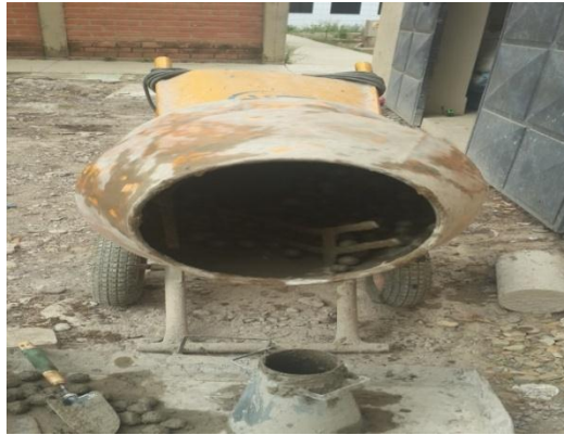
Figura 3.30 Preparación de la mezcla
