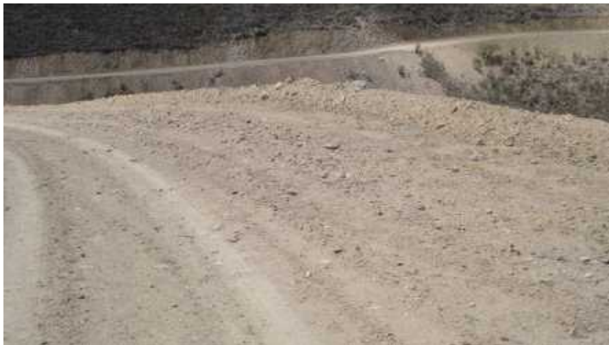
Terraplén N° 2, ubicado en la progresiva 3+560, en el tramo Carlazo – Canchones
