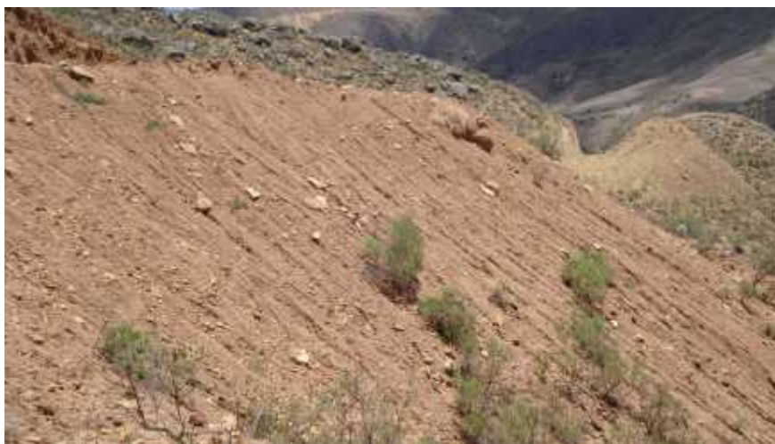
Terraplén N° 1, ubicado en la progresiva 6+220, en el tramo Canchones- Papachacra
