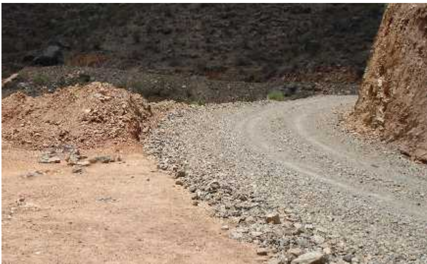
Terraplén N° 3, ubicado en la progresiva 0+020, en el tramo Carlazo – Canchones
