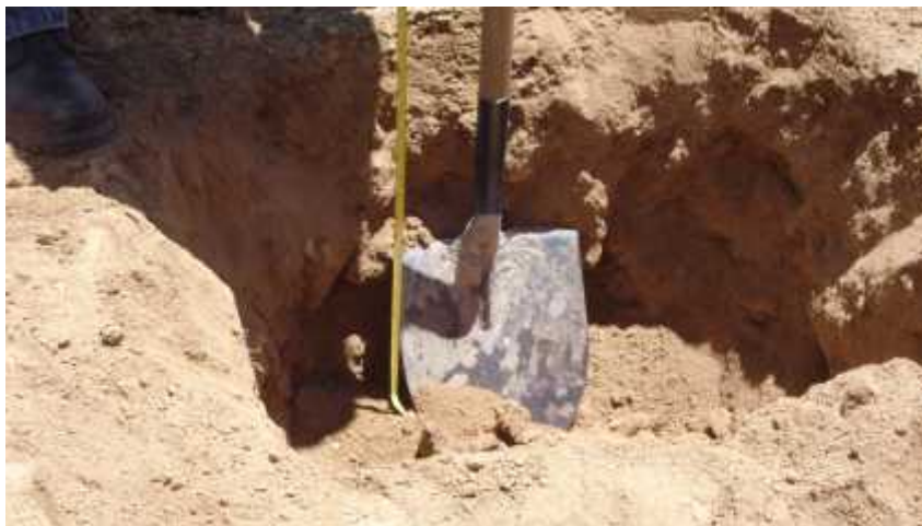
Toma de muestra N° 3, en la progresiva 0+020, en el tramo Carlazo – Canchones
