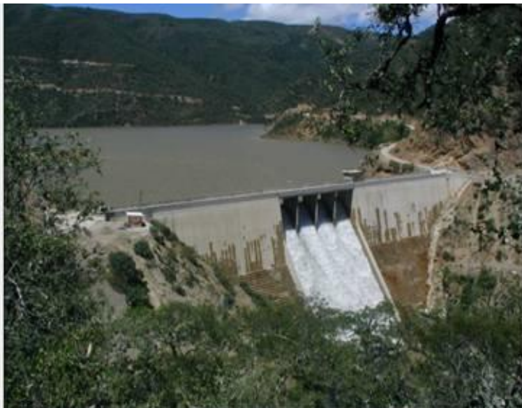
Figura 2.2.1. Presa La Cañada, primera experiencia de HCR en Bolivia
