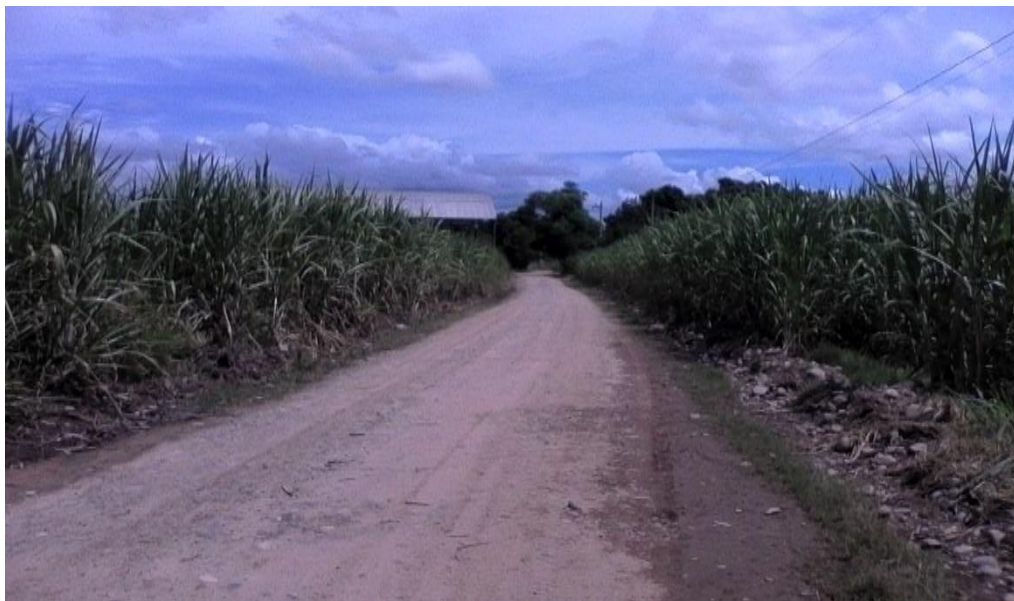
IMAGEN Nro. 9 Vista del lugar progresiva 0+200
