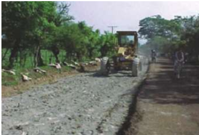
Figura 2.16: Mezclado del suelo, cemento y agua mediante motoniveladora
