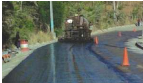
Figura 2.18: Riego de membrana asfáltica de curado
