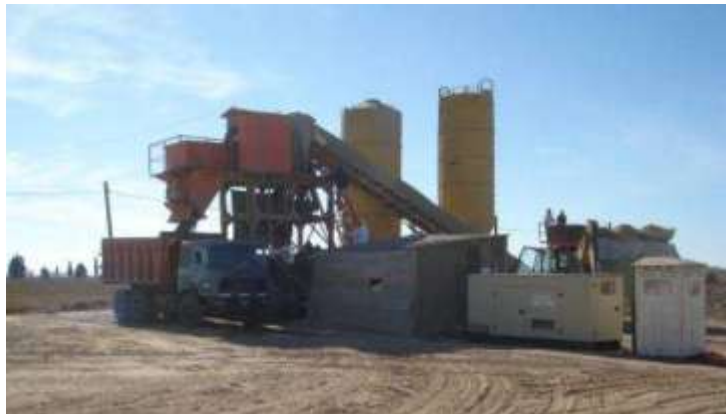
Figura 2.19. Mezclado en planta central
