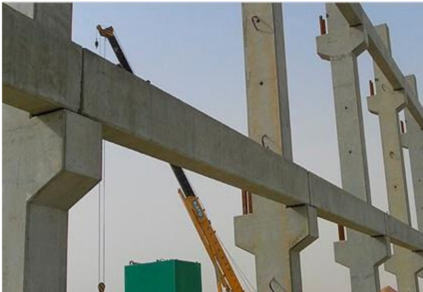
Figura 1.11 Viga Carrilera
