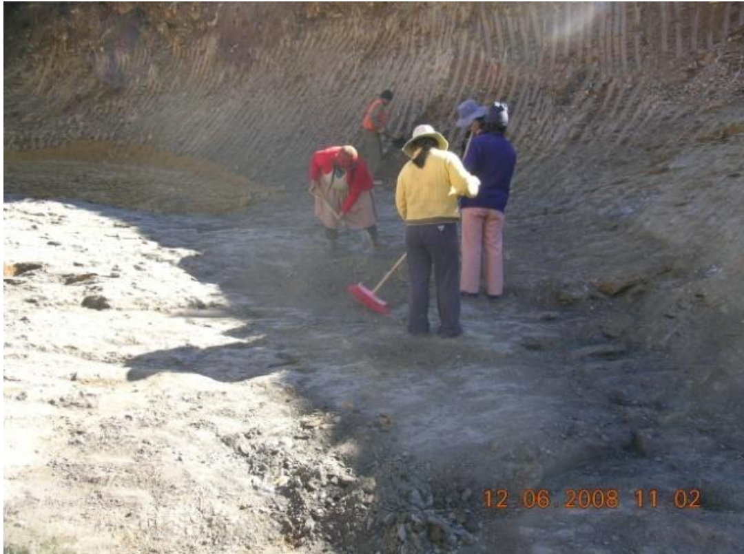
FIGURA6.1 FUNDACIÓN BASAMENTO ROCOSO PRESA LA JARKA “COLÓN NORTE”
