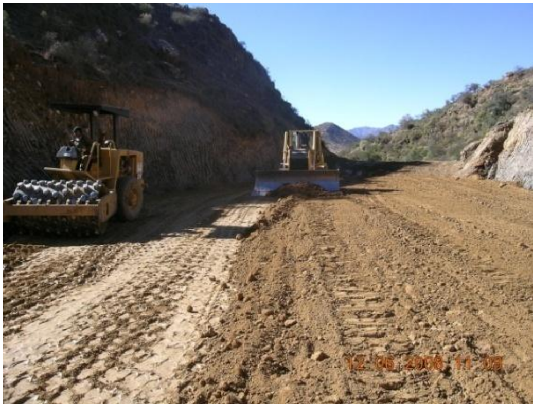
FIGURA6.12 CONFORMADO DE TERRAPLÉN PRESA TRINCHERA “CABILDO”
