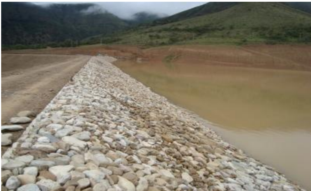
FIGURA6.23 PROTECCIÓN DE TALUD ENROCADO PRESA HONDURA “PAJCHANI”
