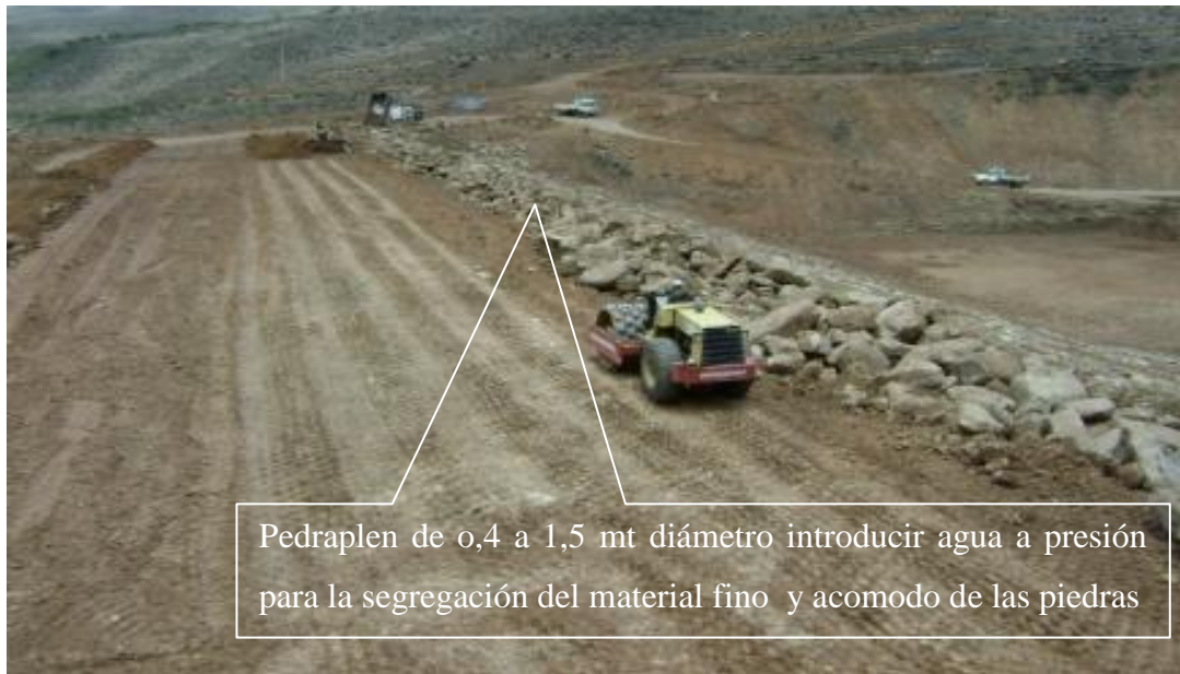
FIGURA6.19 PROTECCIÓN DE TALUD RIP RAP PRESA CASA VIEJA "CHIGUAYPOLLA"
