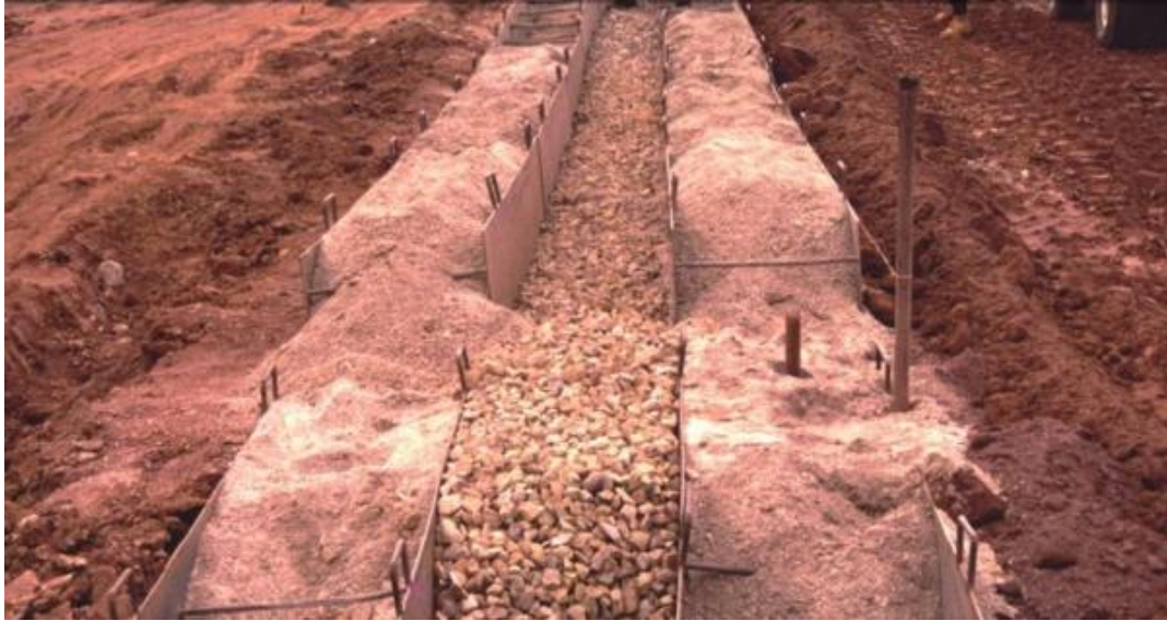
FIGURA4.11 PRESA CON UN DREN VERTICAL
