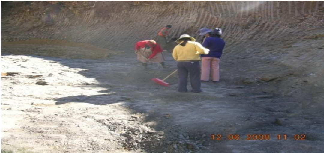
FIGURA4.16 FUNDACIÓN SOBRE BASAMENTO ROCOSO
