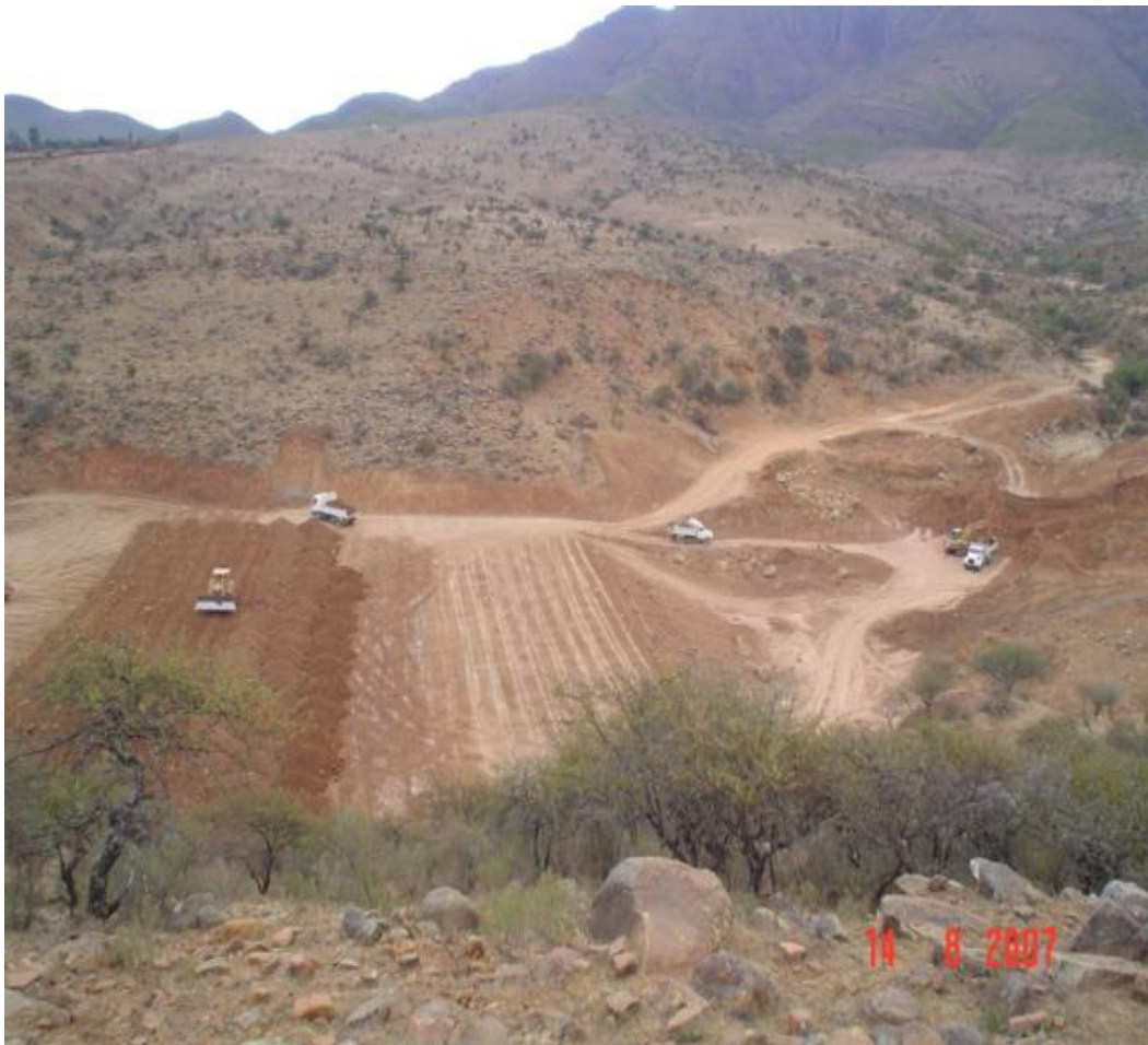
FIGURA6.10 CONFORMACIÓN DE TERRAPLÉN PRESA LA MINA “YESERA CENTRO”
