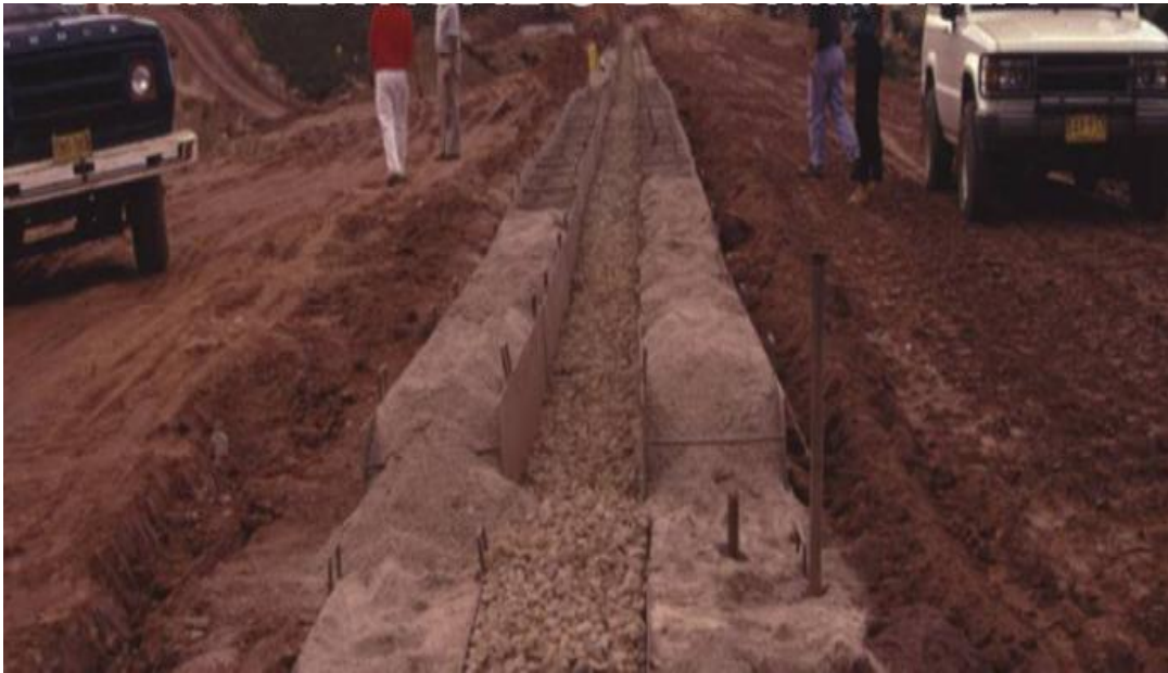
FIGURA4.12 PRESA CON UN DREN VERTICAL
