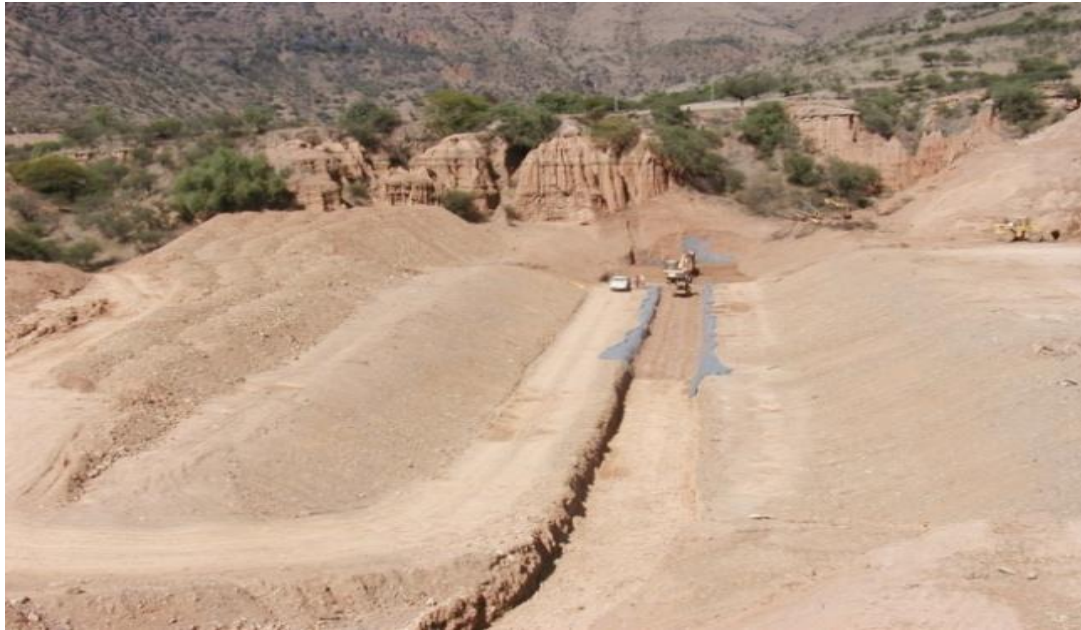
FIGURA4.18 FUNDACIÓN SOBRE MATERIALES PERMEABLES
