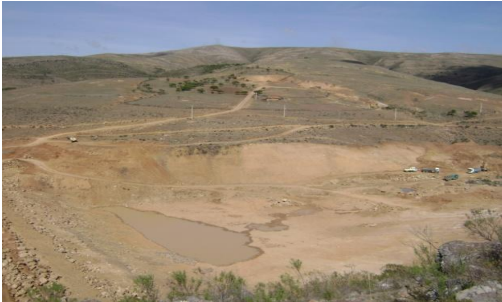
FIGURA6.17 TRABAJOS DENTRO DEL VASO DE ALMACENAMIENTO
