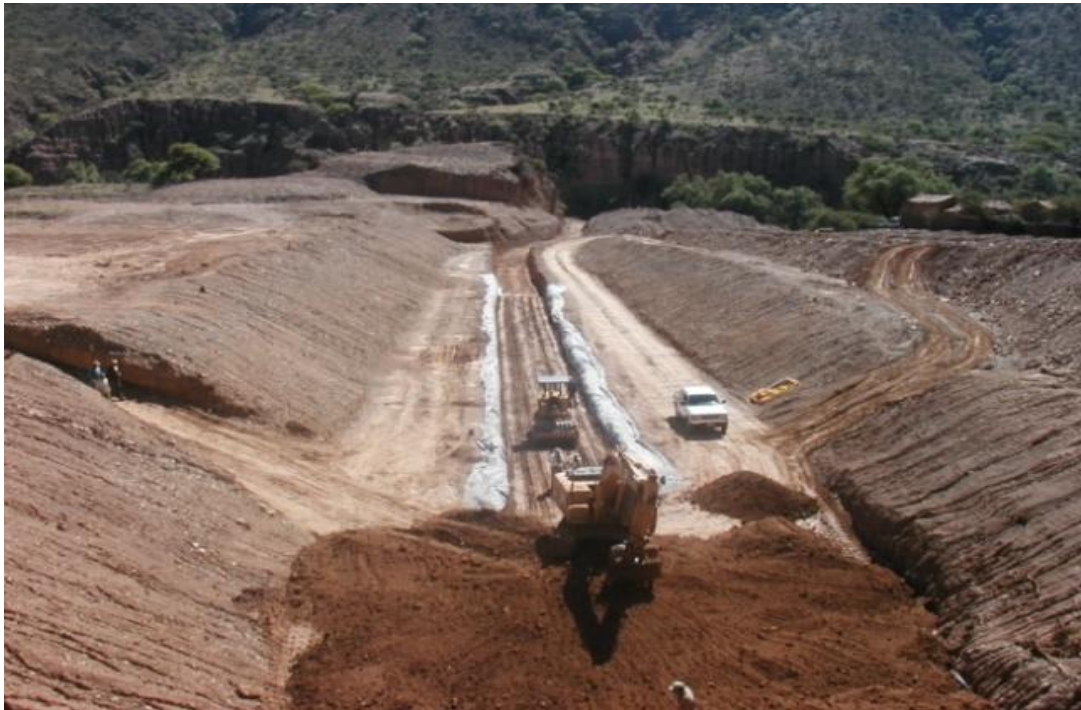
FIGURA4.17 FUNDACIÓN SOBRE MATERIALES PERMEABLES
