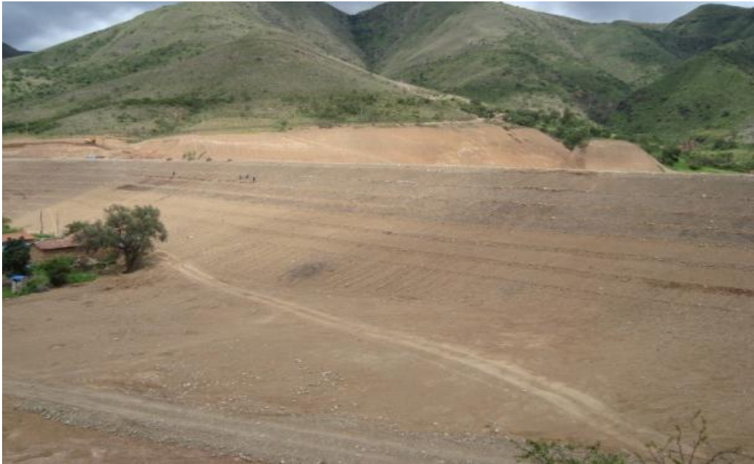
FIGURA6.25 PROTECCIÓN DE TALUD CORDONES DE PIEDRA PRESA LA HONDURA
