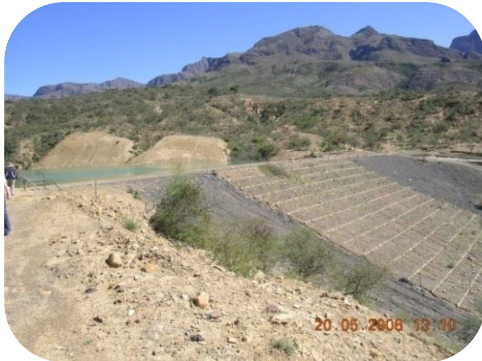
FIGURA6.28 PROTECCIÓN DE TALUD AGUAS ABAJO
