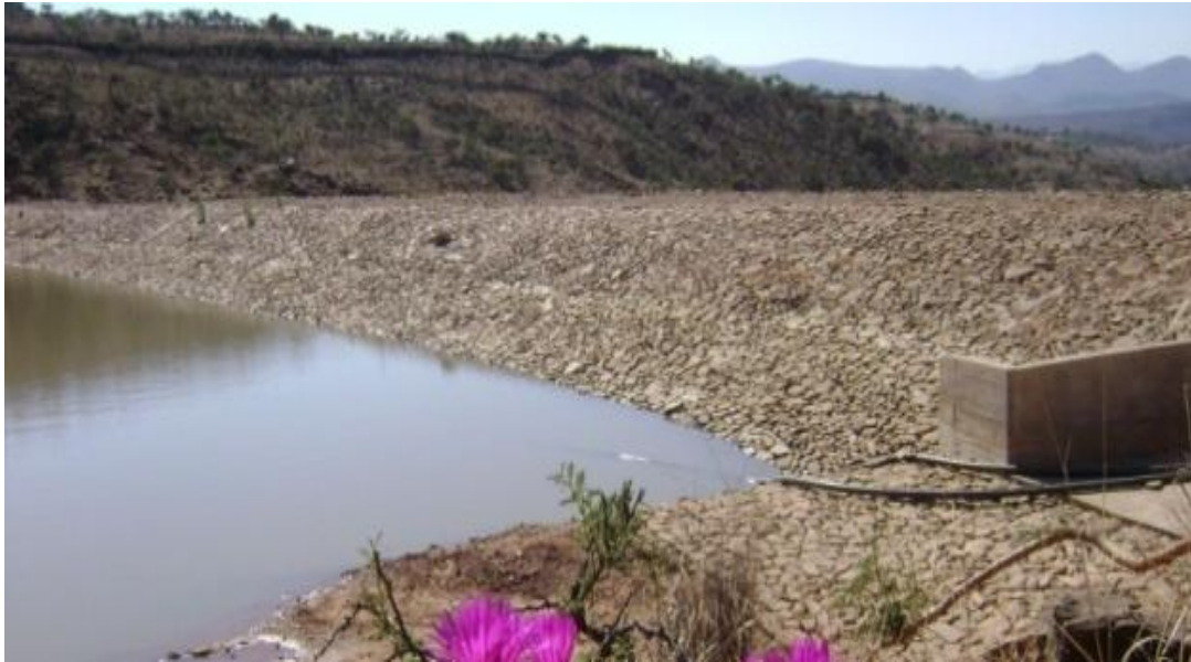
FIGURA6.24 PROTECCIÓN DE TALUD ENROCADO PRESA LA TIPA “YESERA CENTRO”
