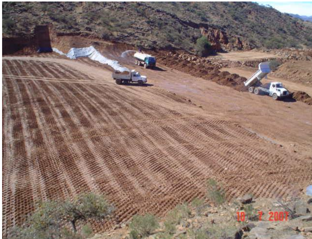
FIGURA6.15 HUMEDECIMIENTO DE AGUA EN EL TERRAPLÉN
