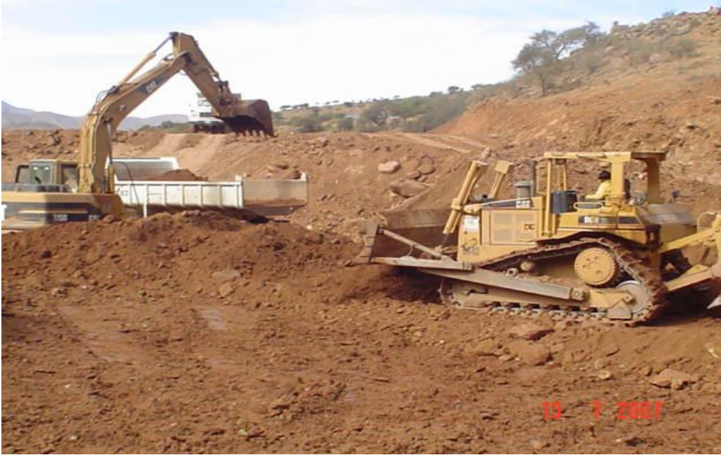
FIGURA6.8 PREPARACIÓN DE MATERIAL PRESA COLPANA “YESERA CENTRO”
