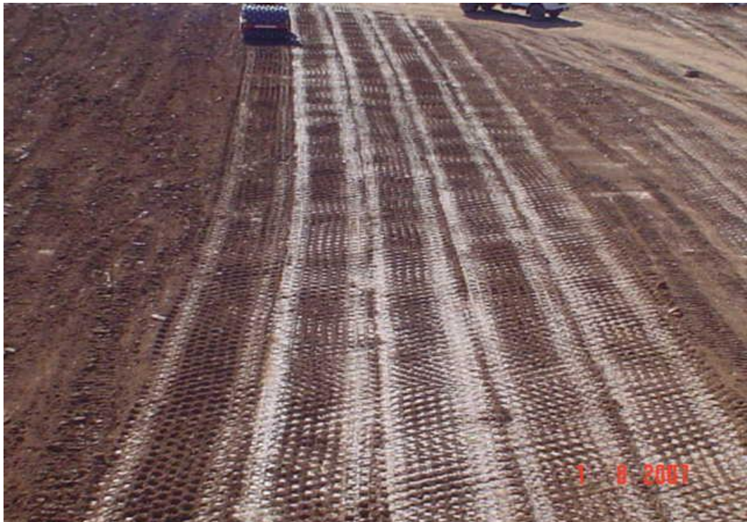
FIGURA6.14 COMPACTACIÓN TERRAPLÉN PRESA ULUPICAS “YESERA CENTRO “
