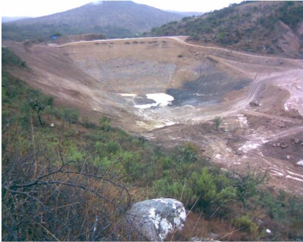
FIGURA6.18 TRABAJOS DENTRO DEL VASO DE ALMACENAMIENTO
