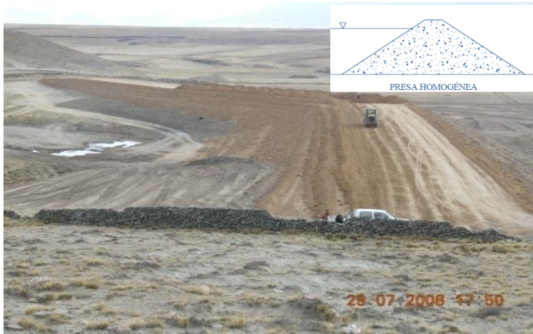
FIGURA4.5 PRESA HOMOGÉNEA ZONA MOLINO "ISLAYACHI"
