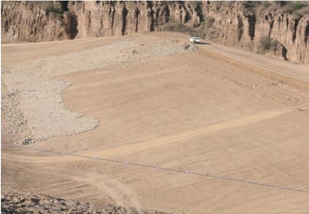
FIGURA6.22 PROTECCIÓN DE TALUD ENROCADO PRESA HONDURA “PAJCHANI”
