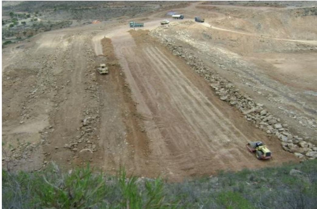
FIGURA6.11 PARALELO CONFORMADO Y COMPACTADO PRESA CASA VIEJA “CHIGUAYPOLLA ”
