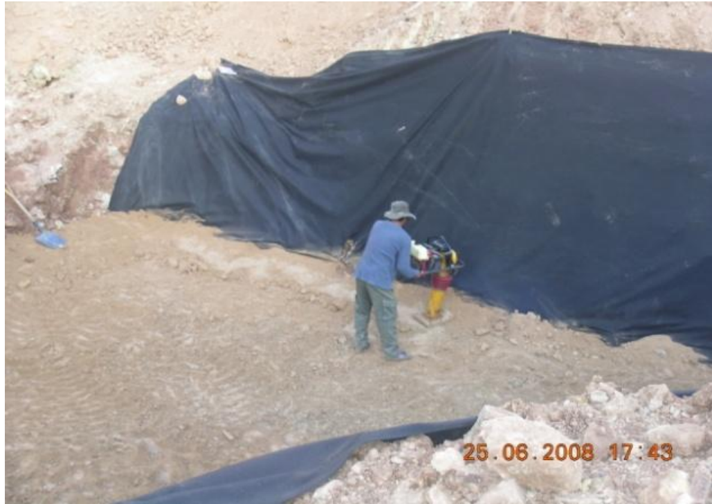
Compactación sectores inaccesibles con Saltarín
