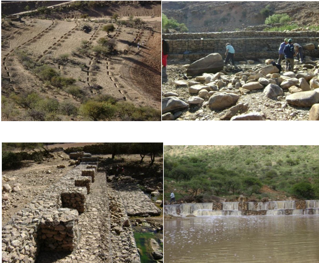
FIGURA6.29 DIQUES DE GAVIONES Y ZANJAS DE INFILTRACIÓN
