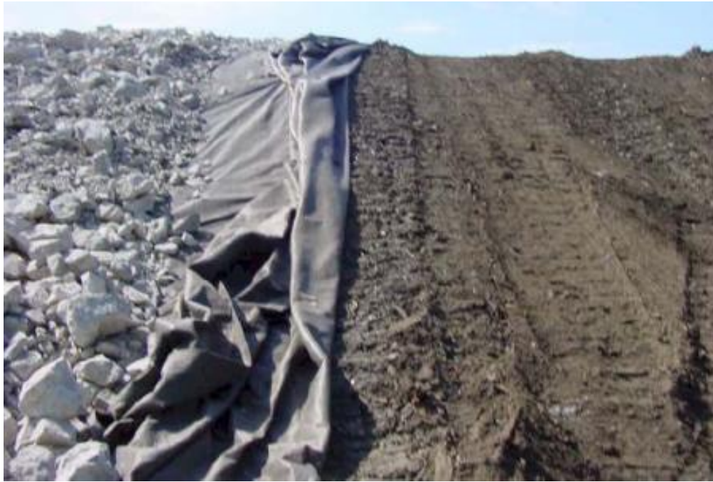
FIGURA6.21 PROTECCIÓN TALUD RIP RAP ROCA TRITURADA “GEOTEXTIL”
