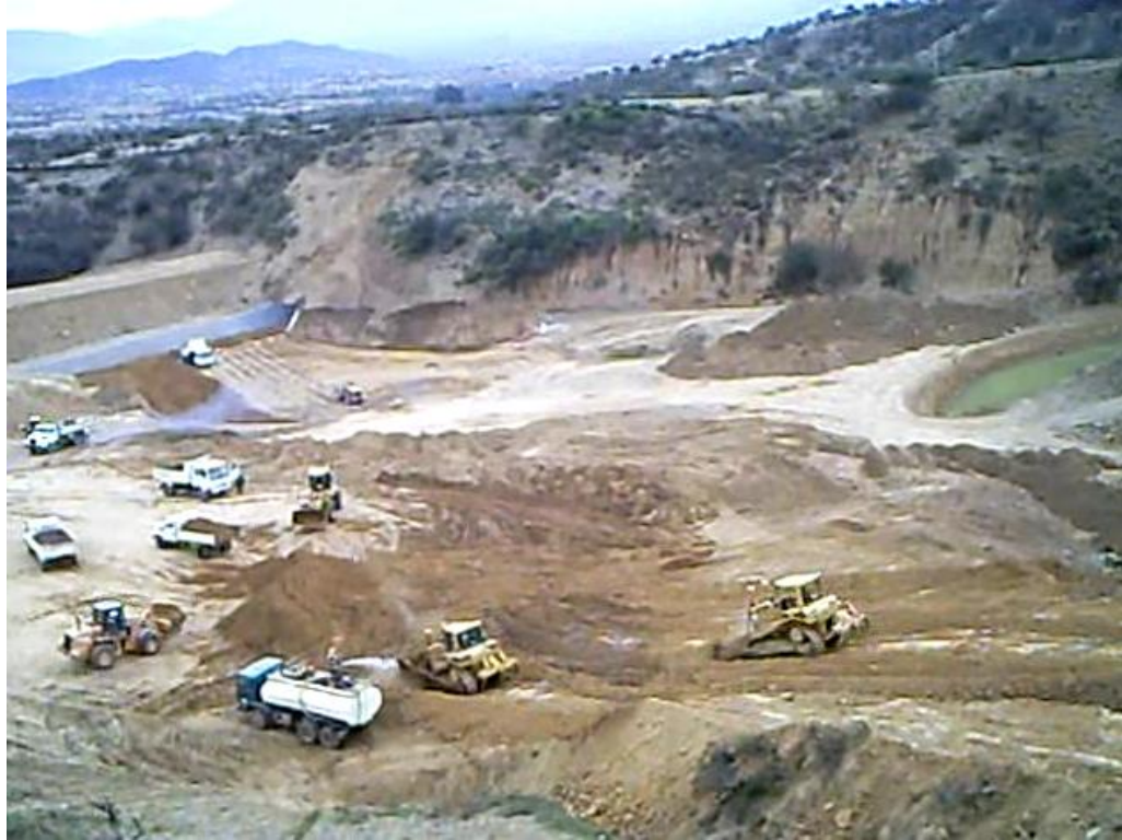
FIGURA6.9 PREPARACIÓN DE MATERIAL PRESA ALGARROBAL “BARRANCAS “
