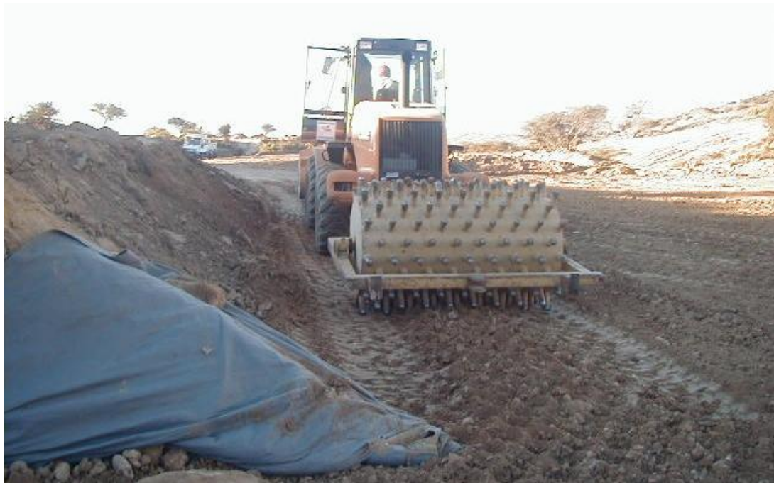
FIGURA4.23 COMPACTACIÓN PATA DE CABRA ESTÁTICO
