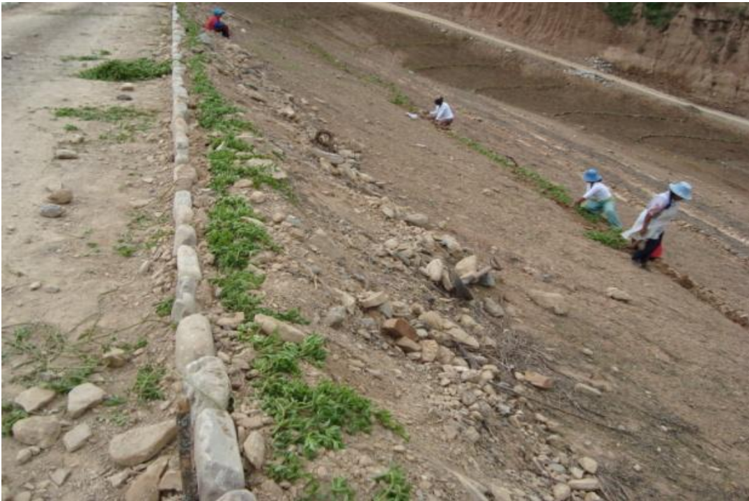
FIGURA6.26 PROTECCIÓN DE TALUD SEMBRADO DE PASTO PRESA LA HONDURA
