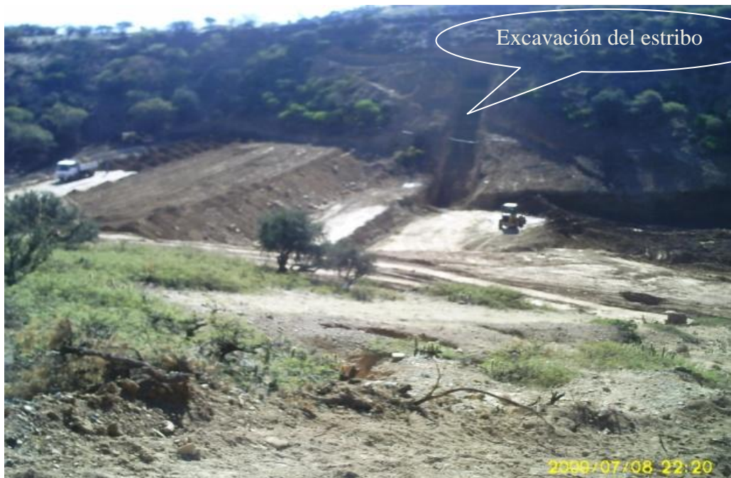
FIGURA6.3 ESTRIBO LATERAL MARGEN DERECHO PRESA ALGARROBAL "BARRANCAS"
