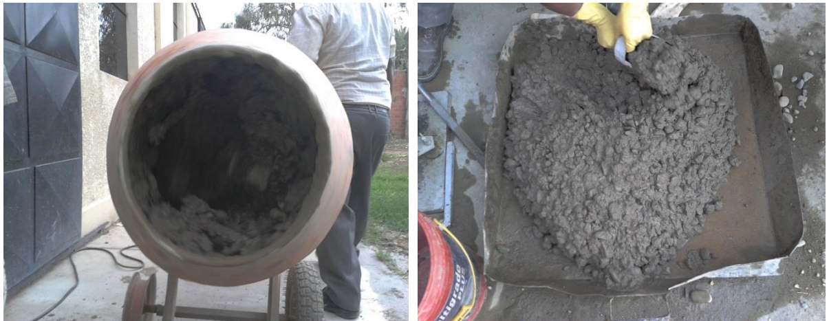
FIGURA 3.2.9-2 MEZCLADO DE LAS MUESTRAS DE HORMIGÓN
