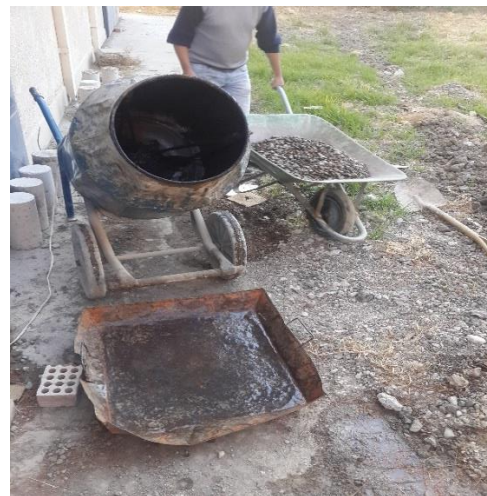
FIGURA 3.2.9-1: MATERIALES YA PESADOS Y LISTOS PARA LA ELABORACIÓN DE LAS MEZCLAS DE HORMIGÓN
