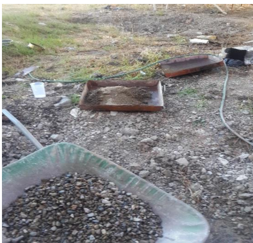
FIGURA 3.2.9-1: MATERIALES YA PESADOS Y LISTOS PARA LA ELABORACIÓN DE LAS MEZCLAS DE HORMIGÓN
