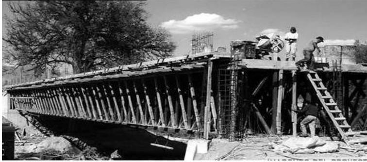
*Ilustración 2 Puente vehicular en ejecución*
