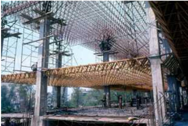
*Ilustración 4 Edificio del Hotel de México, se muestra la elaboración de las tridilosas*
