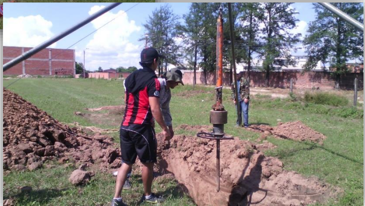
Ilustración 4: Ensayo de SPT. Fuente: Elaboracion propia.
