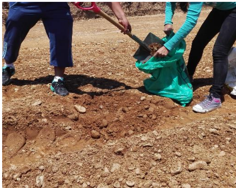
Figura 4.7. Material de la Sub-base
