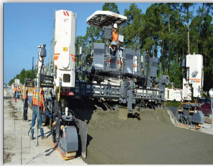
Figura 2.7. Transporte del hormigón
