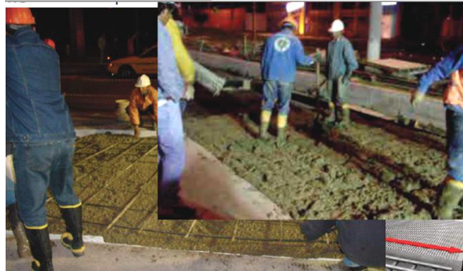
Figura 2.8. Puesta en obra del hormigón
