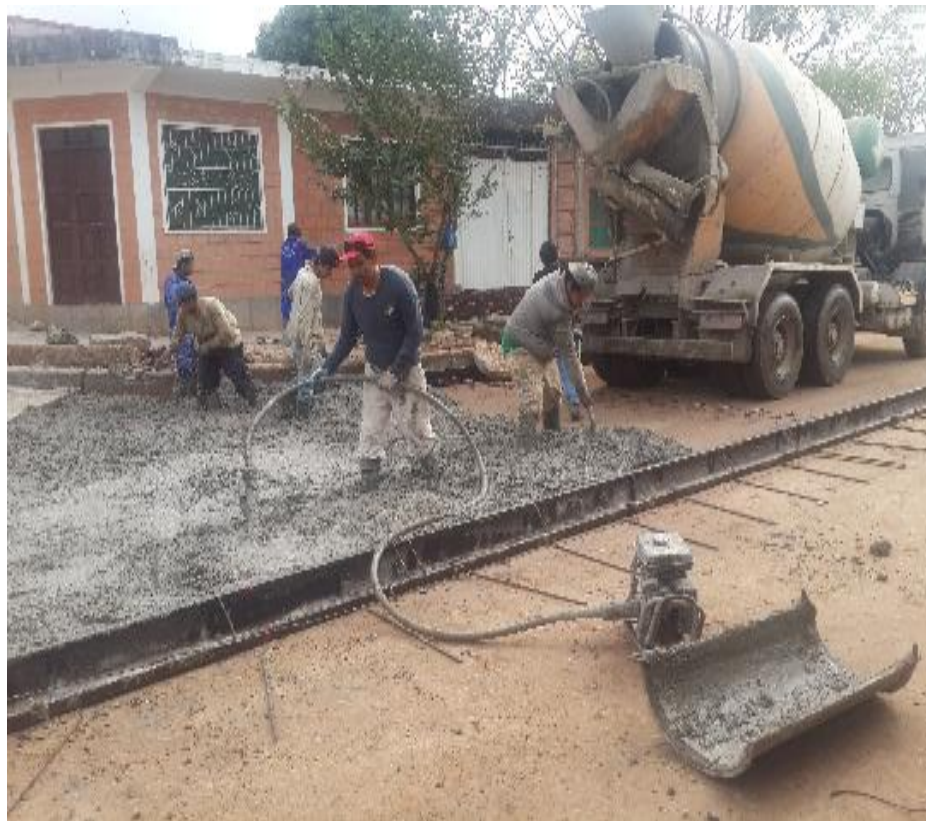
Figura 4.16. Vaciado del hormigón en las calles de estudio
