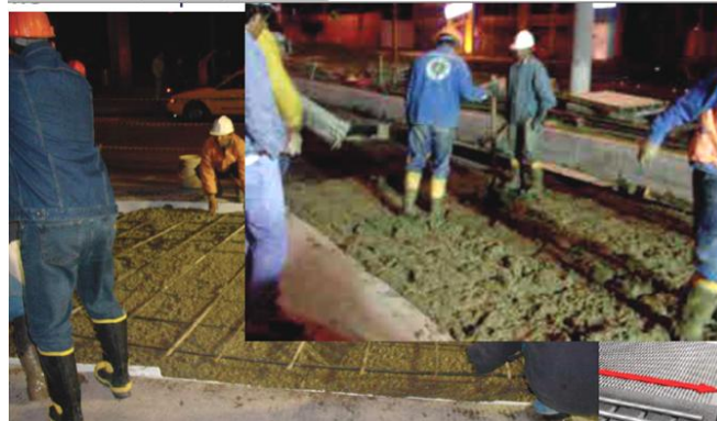
Figura 2.8. Puesta en obra del hormigón
