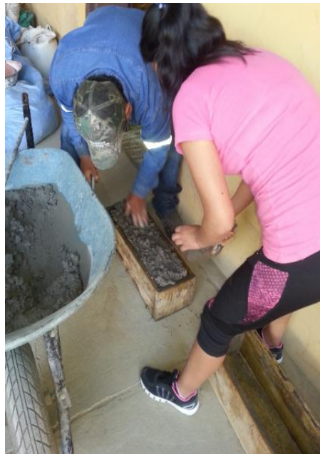
Figura 4.22. Preparación de las vigas
