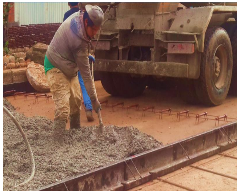
Figura 4.27. Colocado de pasajuntas
