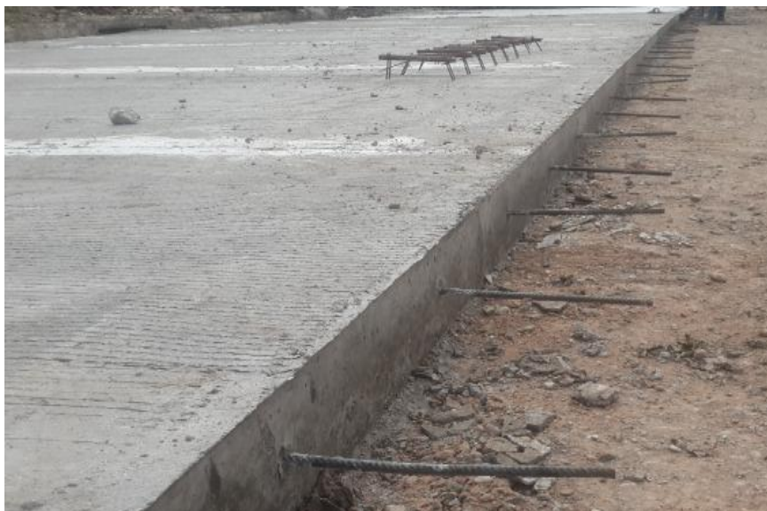
Figura 4.29. Armadura en la junta longitudinal
