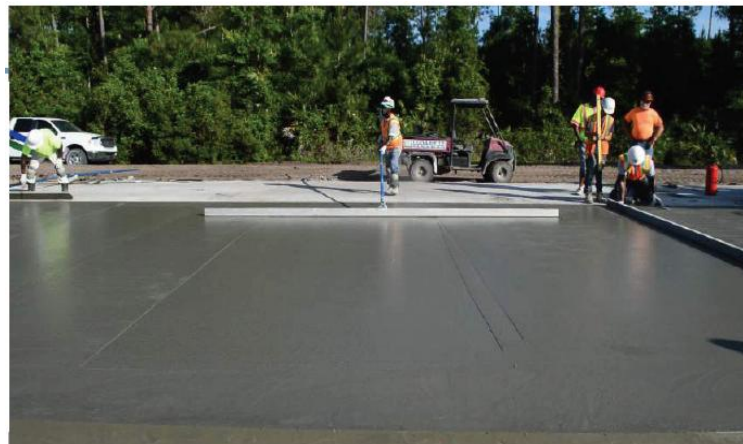
Figura 2.9. Acabado y texturado del hormigón
