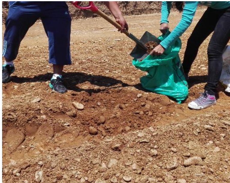
Figura 4.7. Material de la Sub-base
