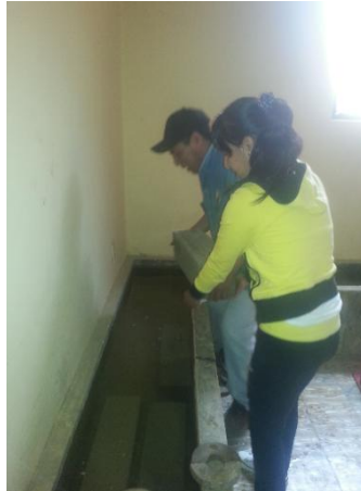
Figura 4.23. Curado de Vigas
