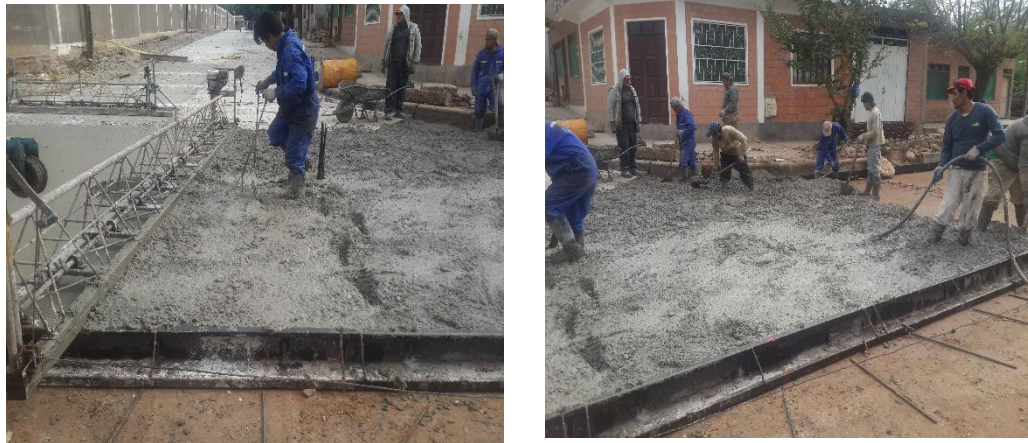
Figura 4.8. Material para vigas y probetas
