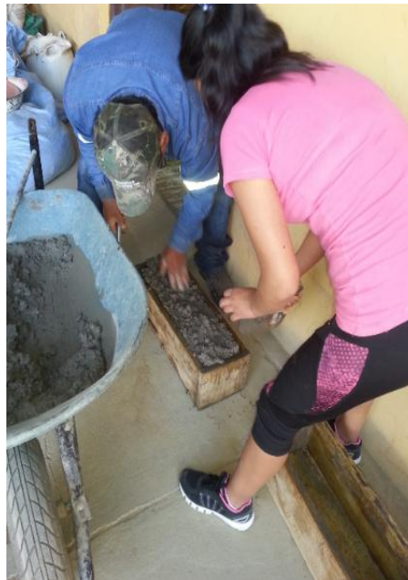
Figura 4.22. Preparación de las vigas
