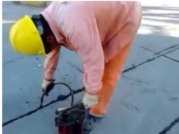
Figura 4.31. Sellado de juntas
