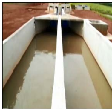
Fotografía 4.3 Desarenador de flujo horizontal en paralelo
