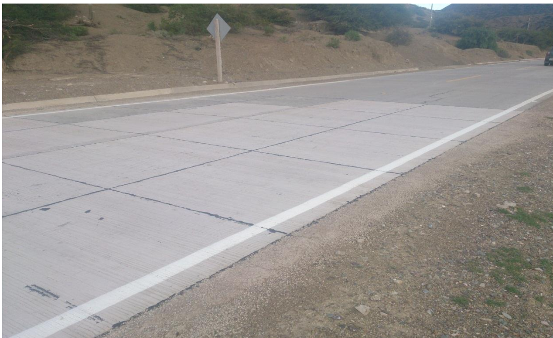
Figura 1.1: Reemplazo de la losas de pavimento rígido
