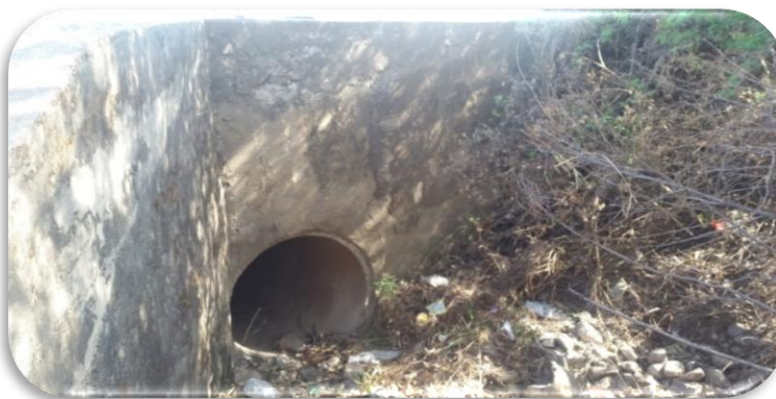
Imagen N°30. Medición de Alcantarillas
