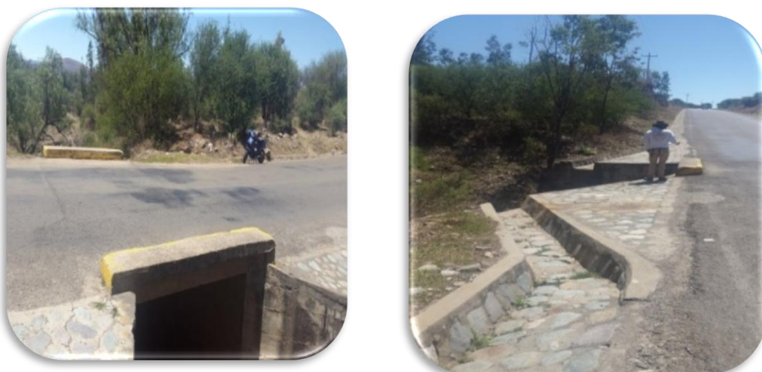
Imagen N°32. Medición de Puentes
