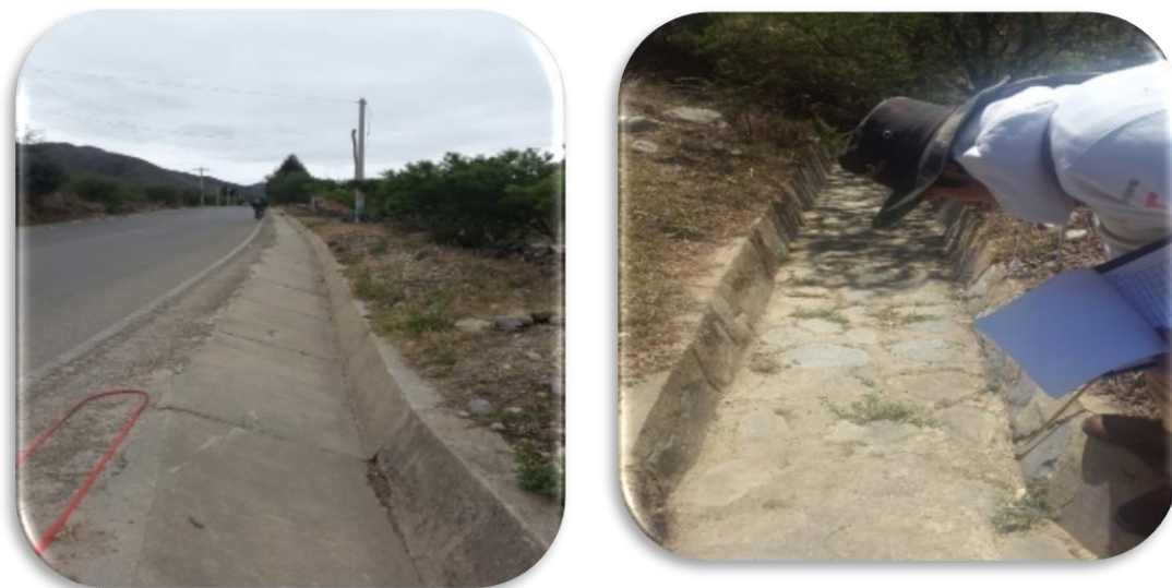
Imagen N°31. Medición de cunetas
