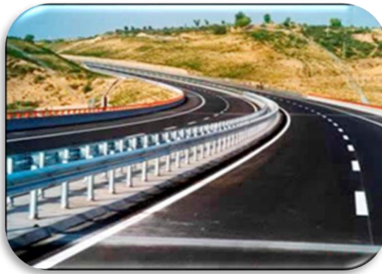
Imagen N°7. Barandas de defensa
