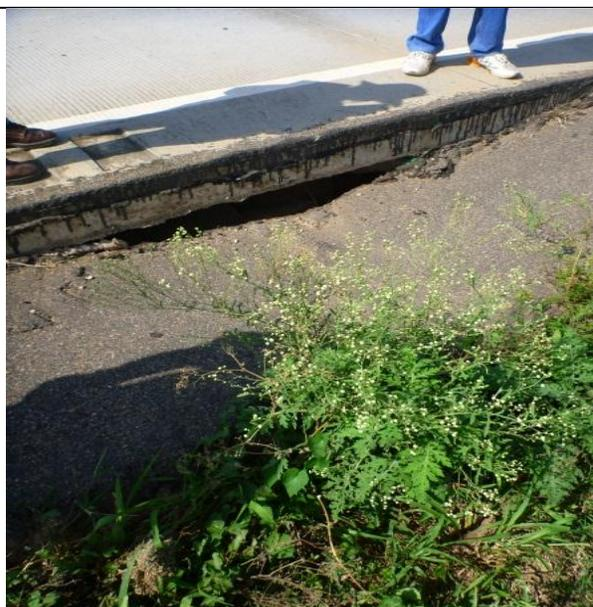
Losa de hormigón vista, debido a la falla de la berma la cual presenta un desplazamiento de al menos 30 cm, por lo cual se tiene una zona muy vulnerable a que el agua pueda ingresar a la sub-base como lo viene haciendo en algunos tramos lavando finos y dejando material faltante en la sub base y también resulta vulnerable el cuerpo de terraplén.
