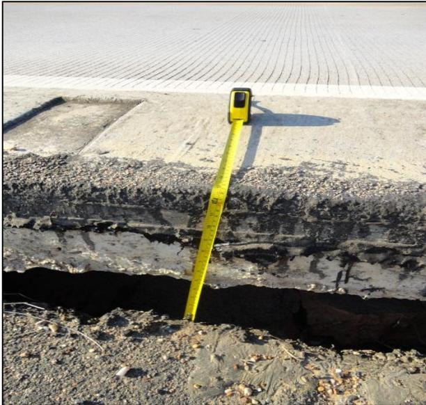
Grieta que tiene una separación variable de 5 a 10 cm, además que se tiene un hundimiento de las bermas.
