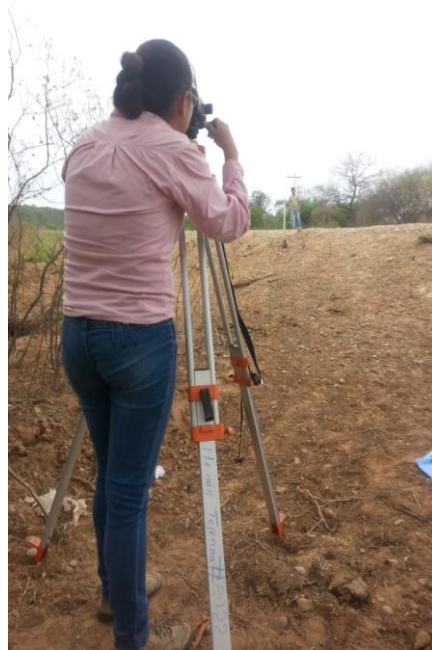
Imagen 8 Realizando la Nivelación
