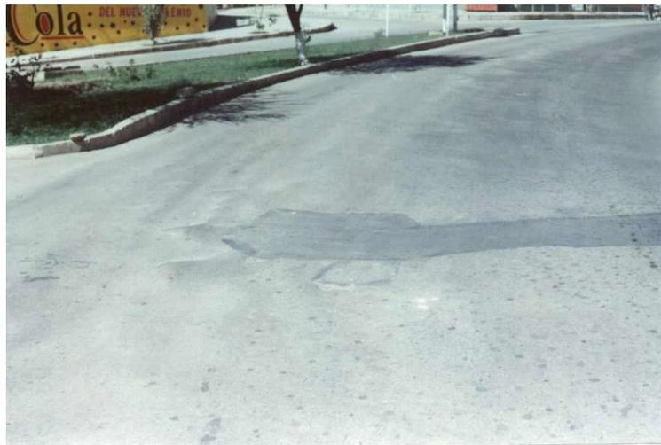
Fig. 2.20. Bacheo y Zanjas Reparadas
