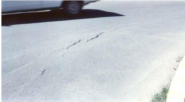
Fig. 2.26. Grietas de deslizamiento
