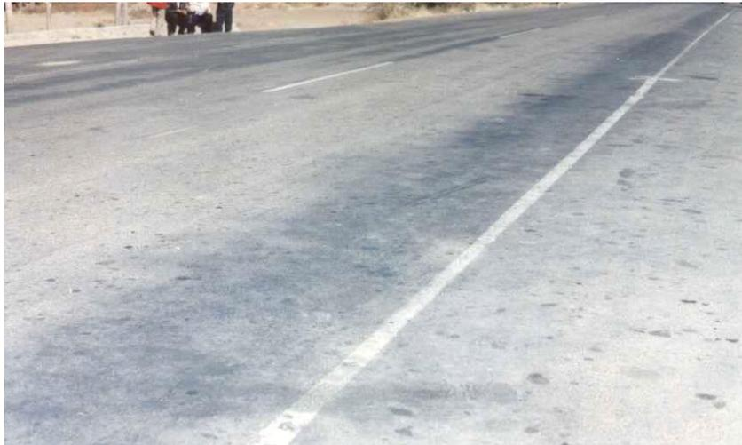
Fig. 2.11. Exudación del Asfalto
