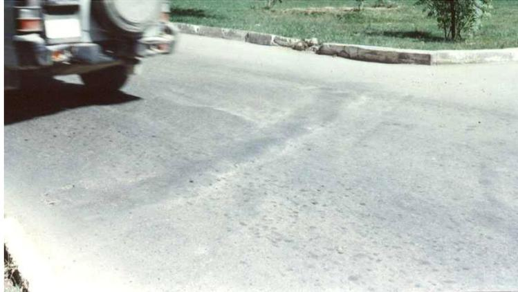
Fig. 2.25. Deformación por Empuje
