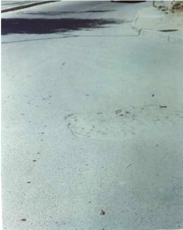
Fig. 2.28. Disgregación y Desintegración
