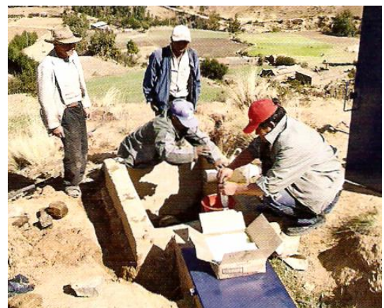
Foto 8: Limpieza de tuberías y cámaras Fuente: PIEN RIEGO
