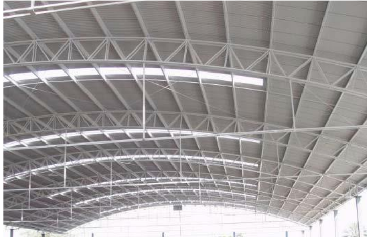
Ilustración 2: Estructura de techo conformada por perfiles laminados tipo C.
