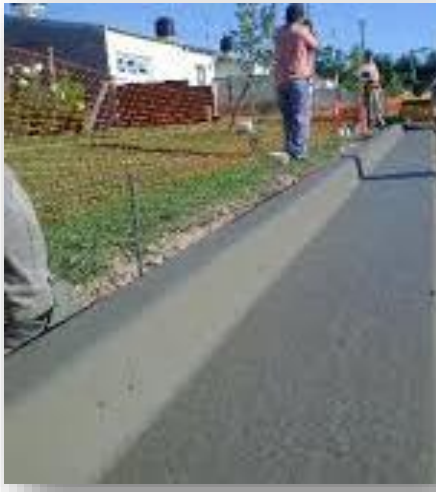
Figura 6. Cordón de andén y cuneta
