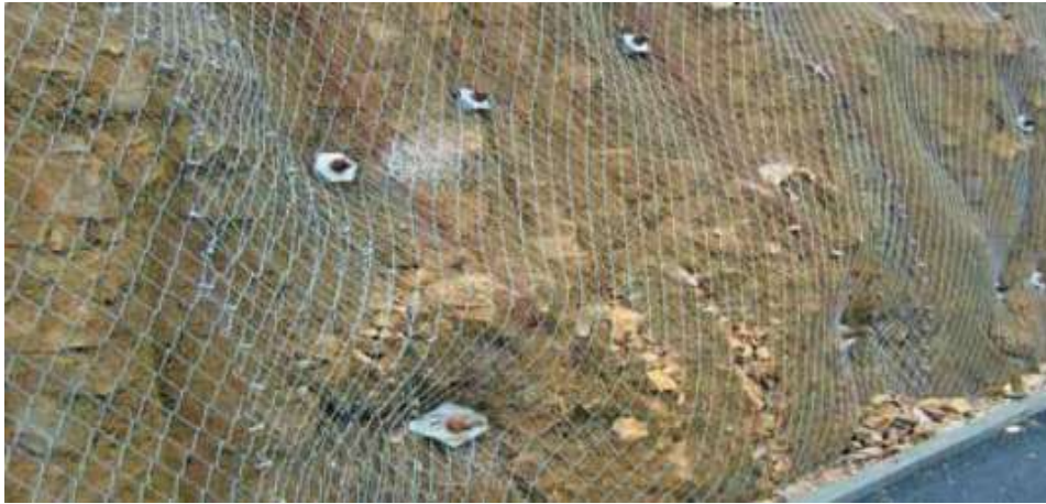
Figura 3.1 malla de acero
