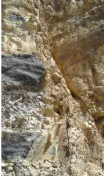
FOTOGRAFÍA N° 18 ubicado en la progresiva 8+800 en el tramo
