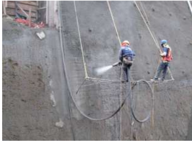
Figura 3.7. Lanzado de concreto en taludes
