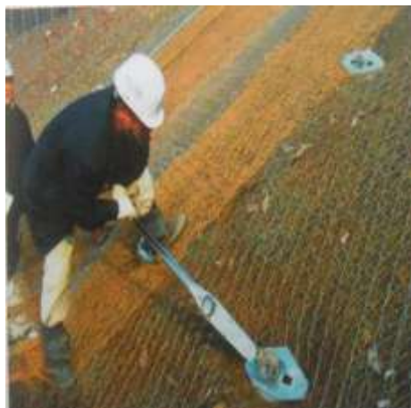
Figura 3.4: a) Placa de fijación del sistema TECCO®. b) Aplicación de la fuerza de pretensión sobre las placas (Geobrugg A Company of the BRUGG Group).
