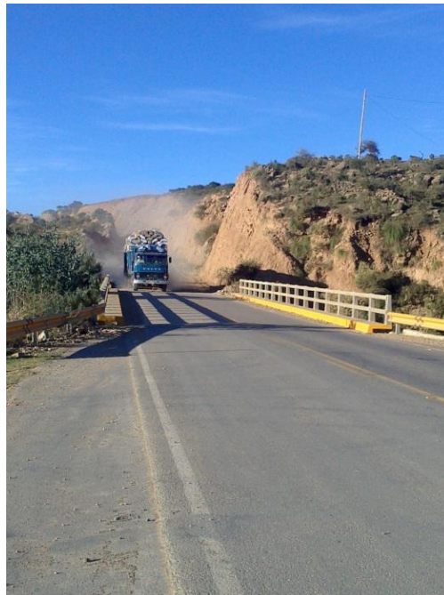
Figura 3.31. Final de evaluación carretera Chaco
