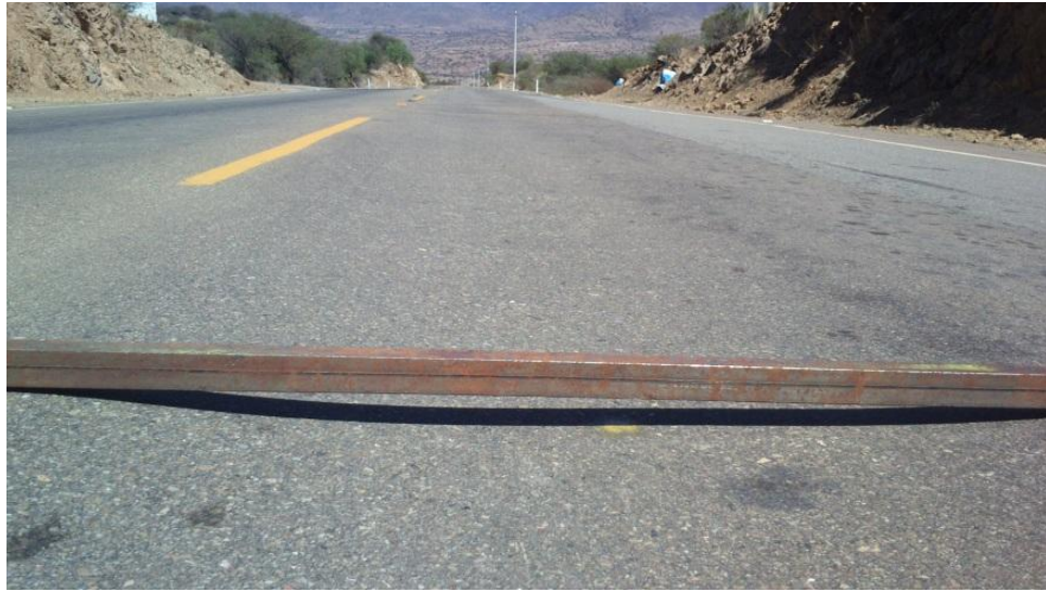
Figura 2.28. Ahuellamiento
