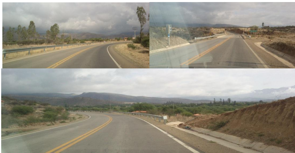
Figura 3.49. Fotografías de obras de protección y zonas inseguras N°3, N°4 y N°5
