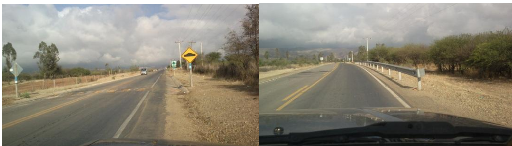
Figura 3.48. Fotografías de obras de protección y zonas inseguras N°1 y N°2
