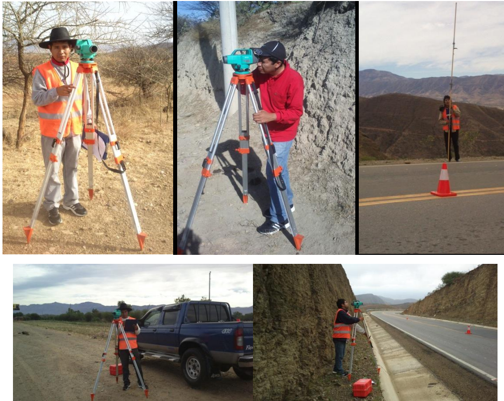
Figura 3.44. Levantamiento con nivel de ingeniero y mira topográfica
