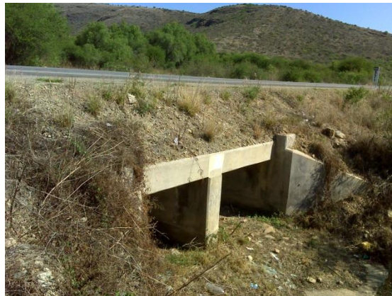
Figura 3.40. Carretera Norte, alcantarilla de grado 3, Prog. 04+540
