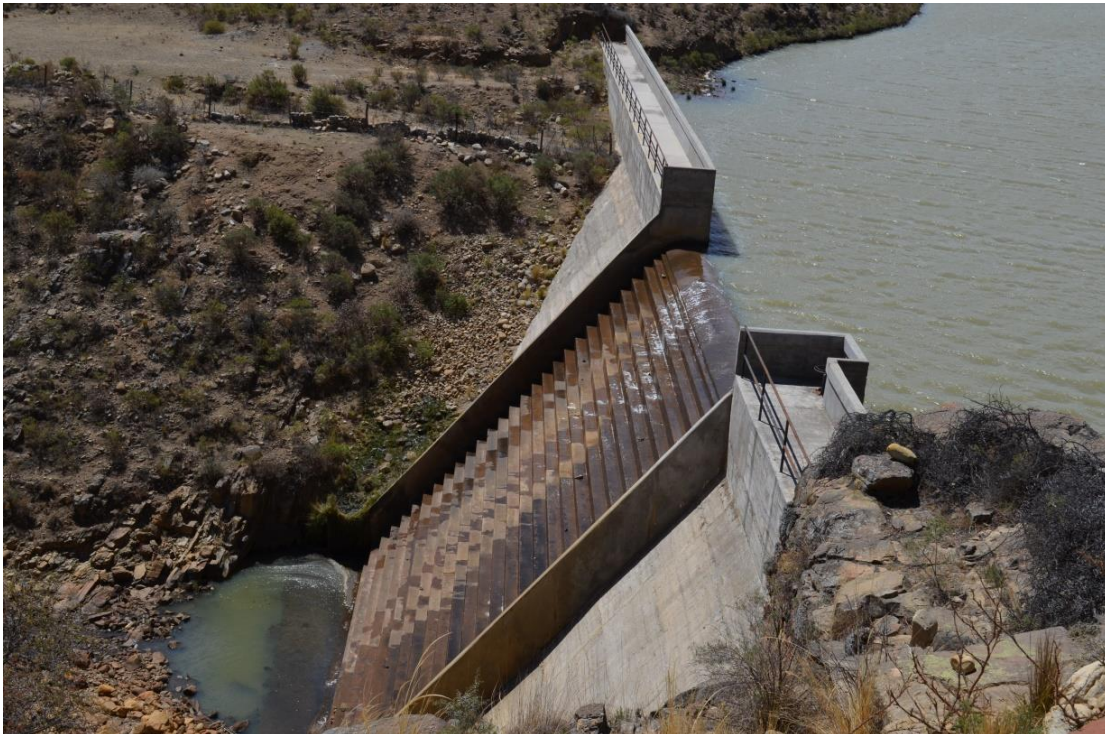
Figura 1.2 Vista del cuerpo de la presa Vuelta de Tiro desde el estribo izquierdo
