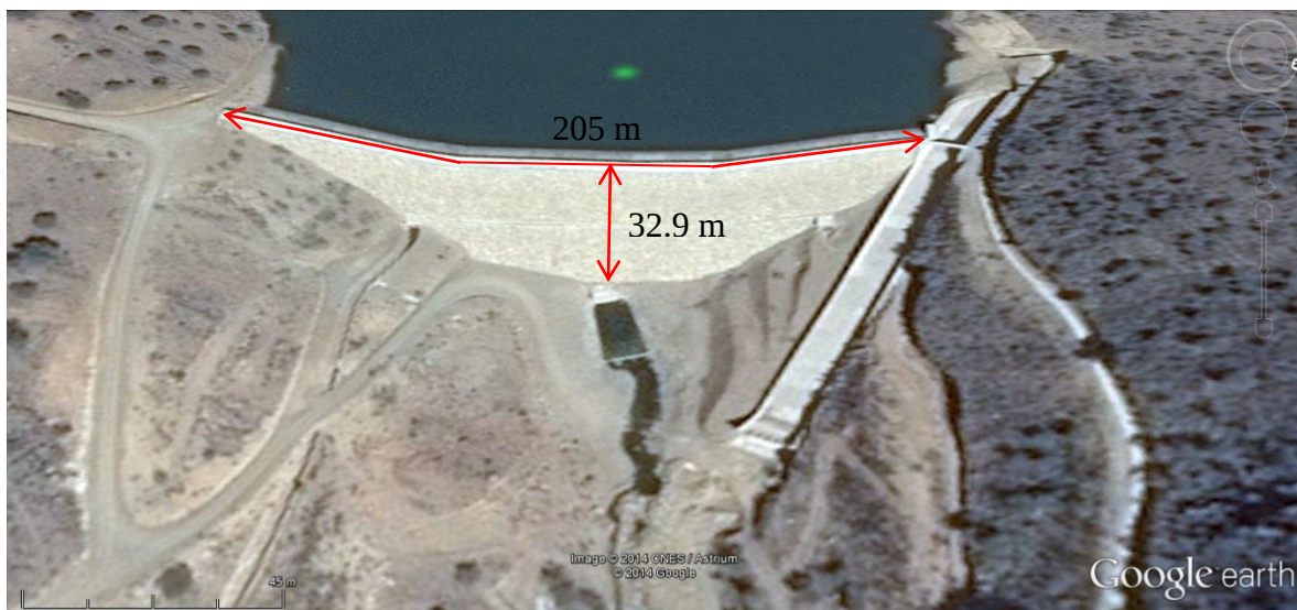
Figura 5.3: Presa de Calderas
