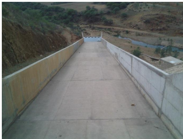
Figura 5.6: Rápida y Salto de Sky de la presa de Calderas
