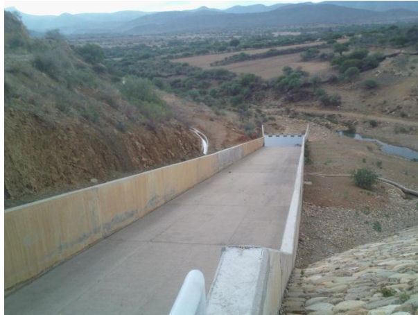
Figura 5.4: Aliviadero de la presa de Calderas
