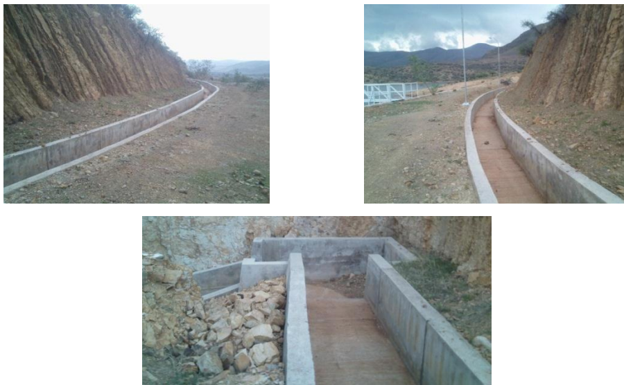
Figura 5.9: Canal de trasvase de la presa de Calderas
