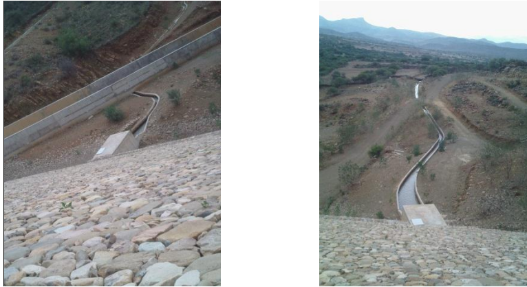
Figura 5.8: Obras de toma de la presa de Calderas
