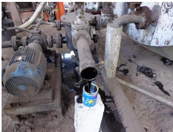
Figura N°4.4 Válvula específica para muestreo de cemento asfáltico
